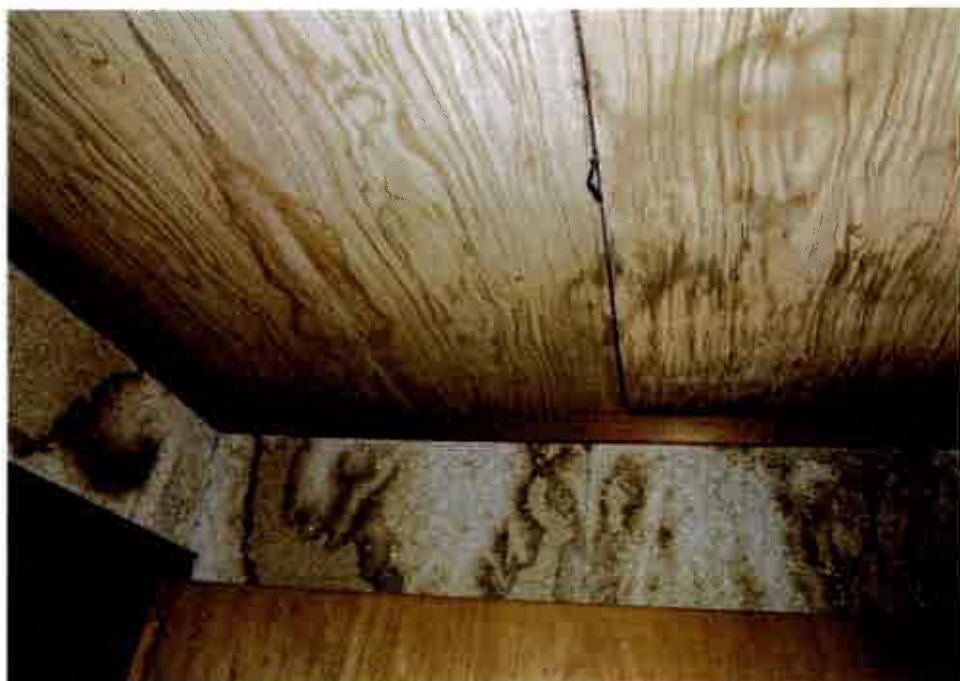
⑦屋内の状況 和室9の天井 の状況
