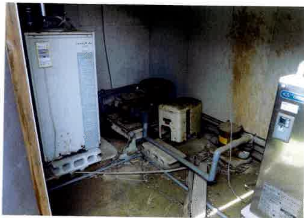
⑨屋内の状況 ボイラー室 (符号4の 附属建物)
