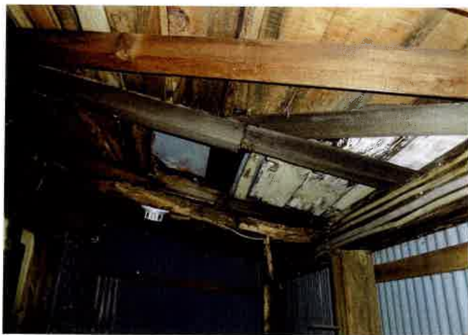
⑥屋内の状況 廊下の天井 の状況
