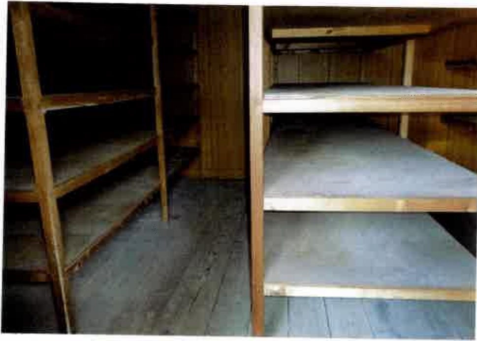
⑬屋内の状況 物置2 (未登記附属 建物2)
