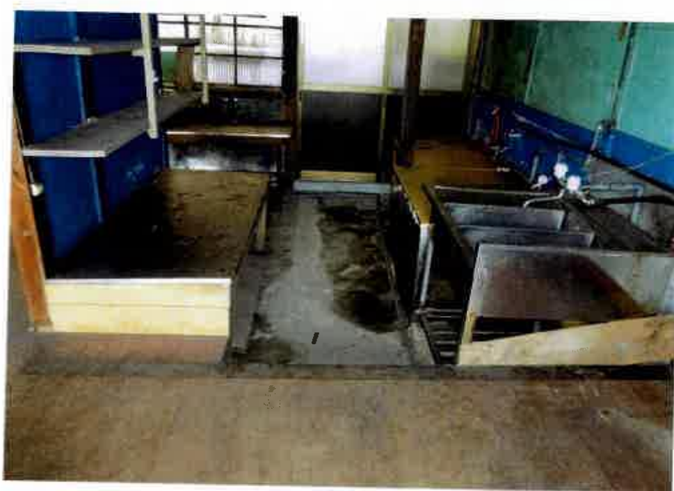
③屋内の状況 炊事場 (土間)
