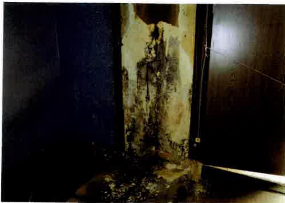
⑤屋内の状況 和室1の壁 の状況
