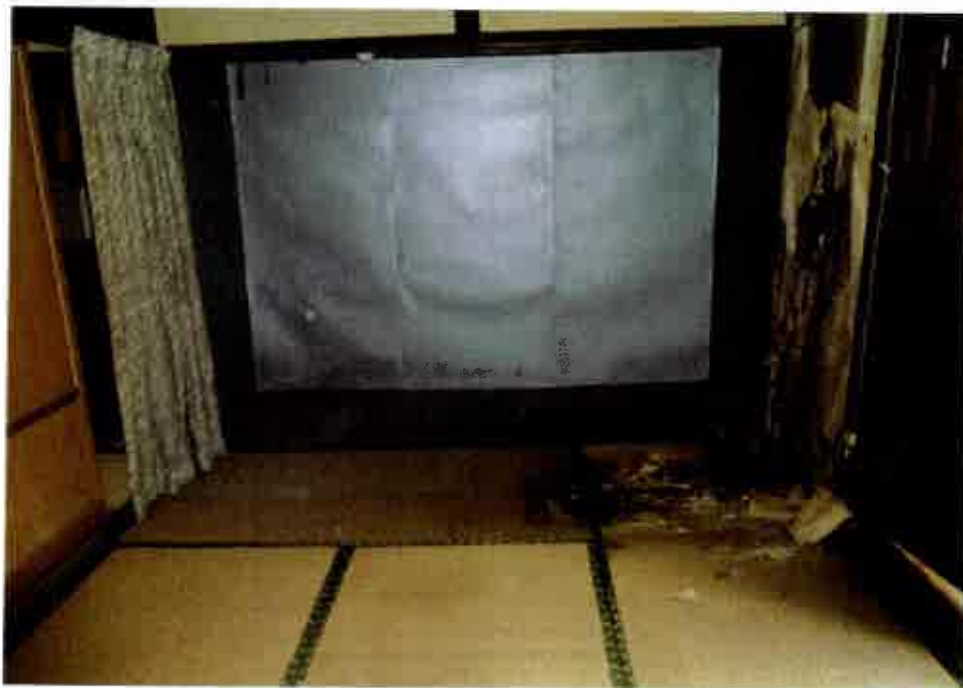
②屋内の状況
