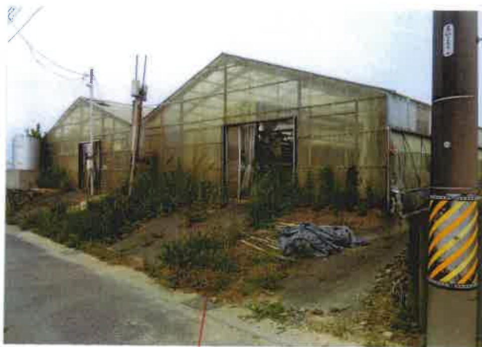
②南西側境界 付近の状況
