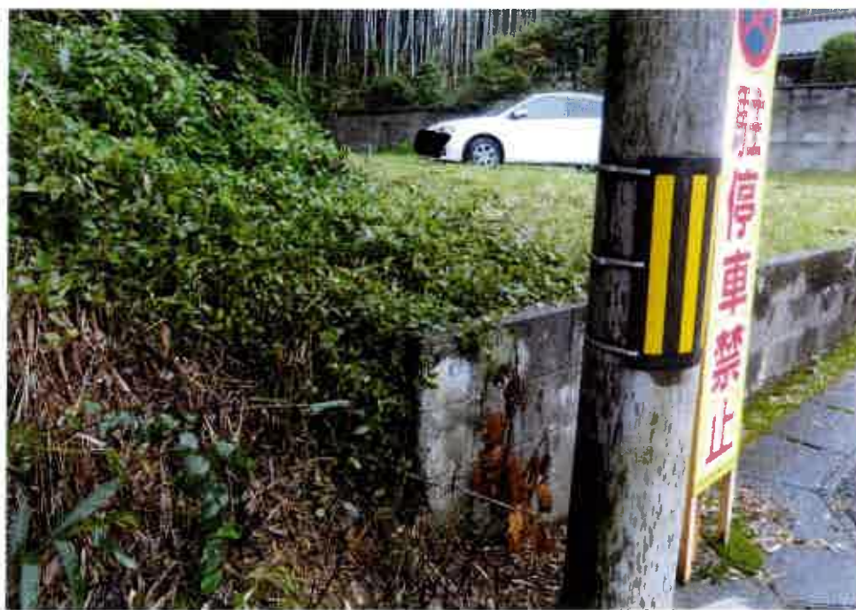
④東側境界 付近の状況
