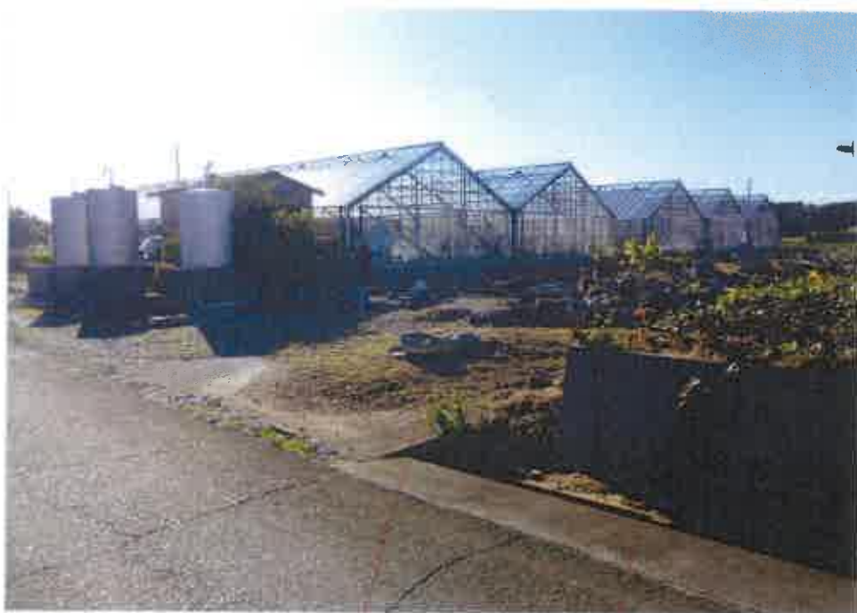
④北東側境界 付近の状況
