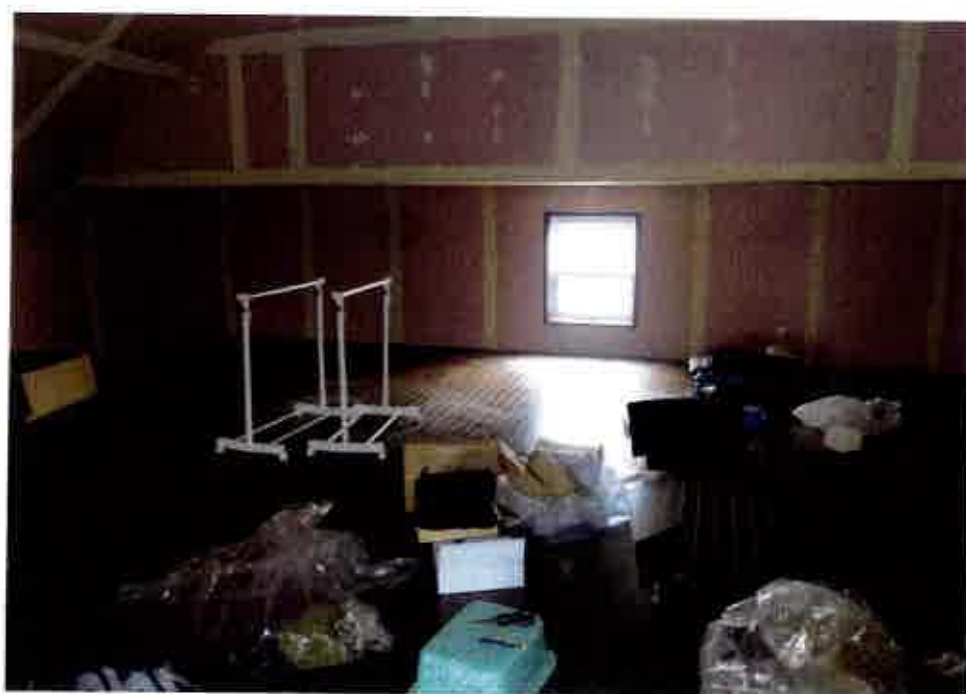
⑥屋内の状況 2階物置
