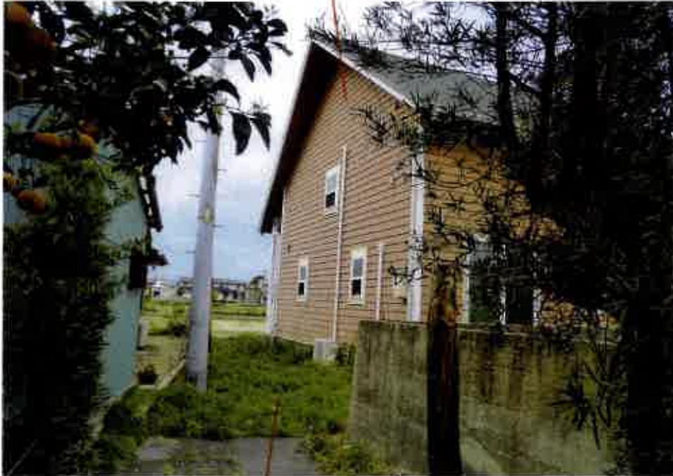
①屋外の状況 (南西側から 撮影)
