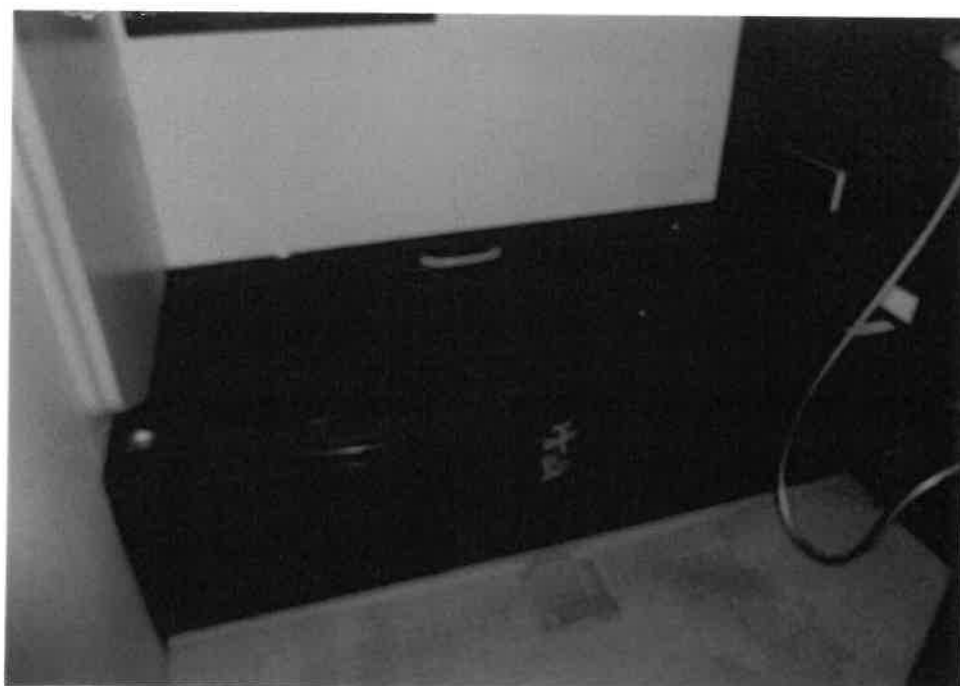
④屋内の状況 浴室
