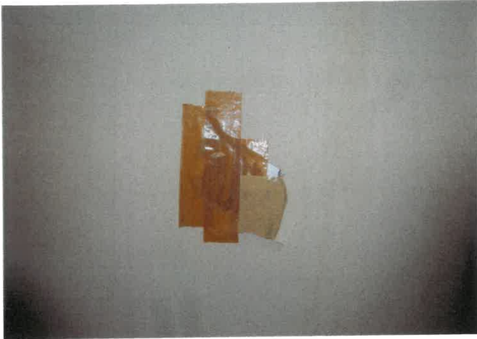
⑦屋内の状況 2階洋室1の 壁の状況
