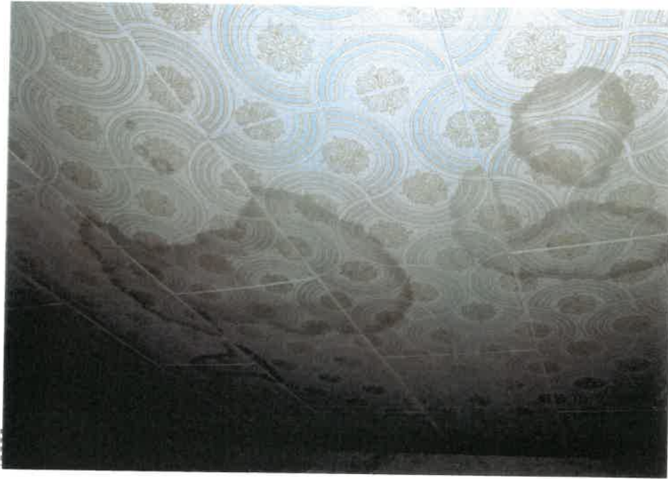
⑬屋内の状況 和室2の天井 の状況 (物件9) (符号1の 附属建物)
