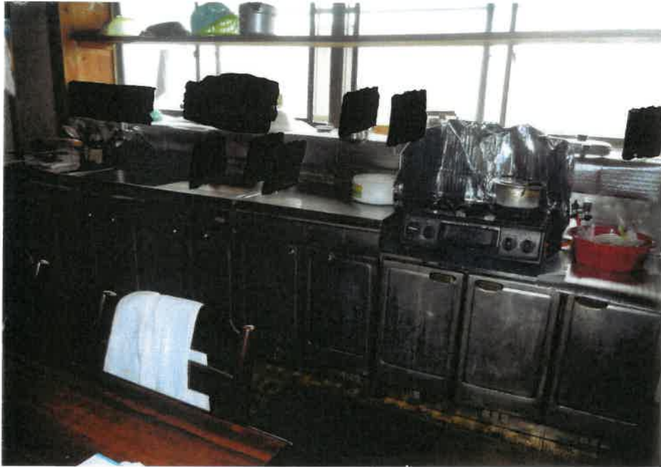
⑨屋内の状況 DK (物件9) (主である 建物)
