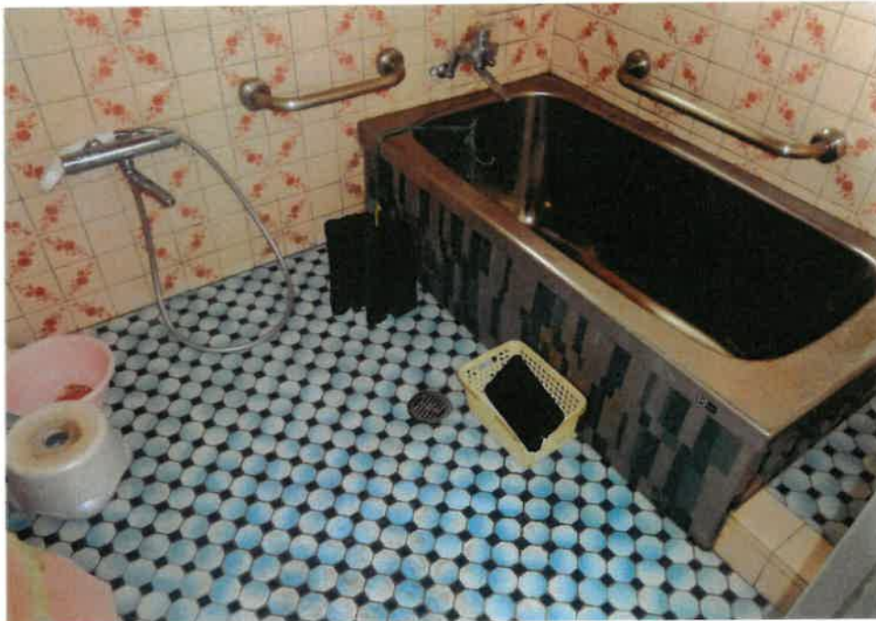
⑩屋内の状況 浴室 (物件9) (主である 建物)
