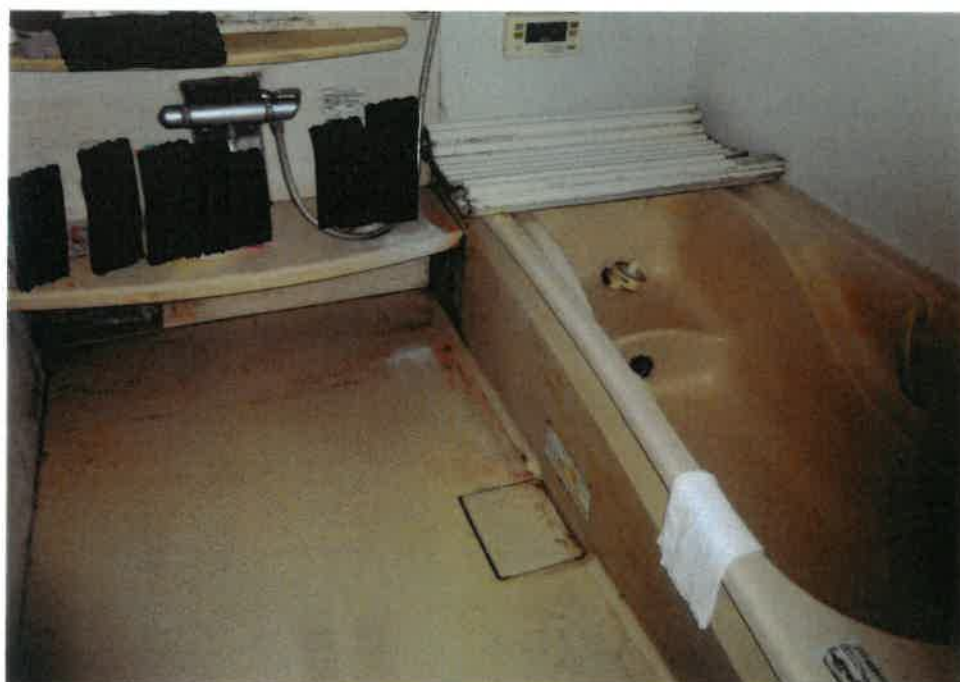
④屋内の状況 浴室
