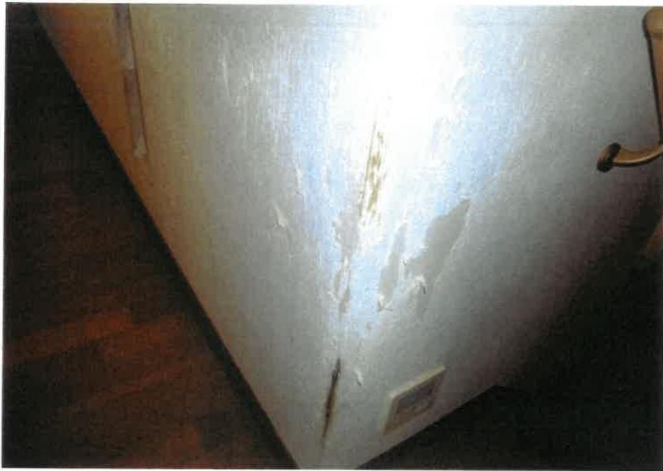
⑤ 屋内の状況 2階廊下の 壁の状況
