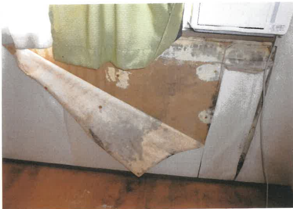
⑤屋内の状況 洋室3の壁の 状況
