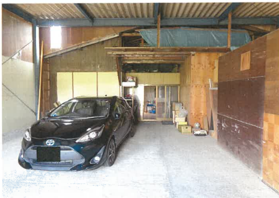
屋内の状況(未登記附属建物)
