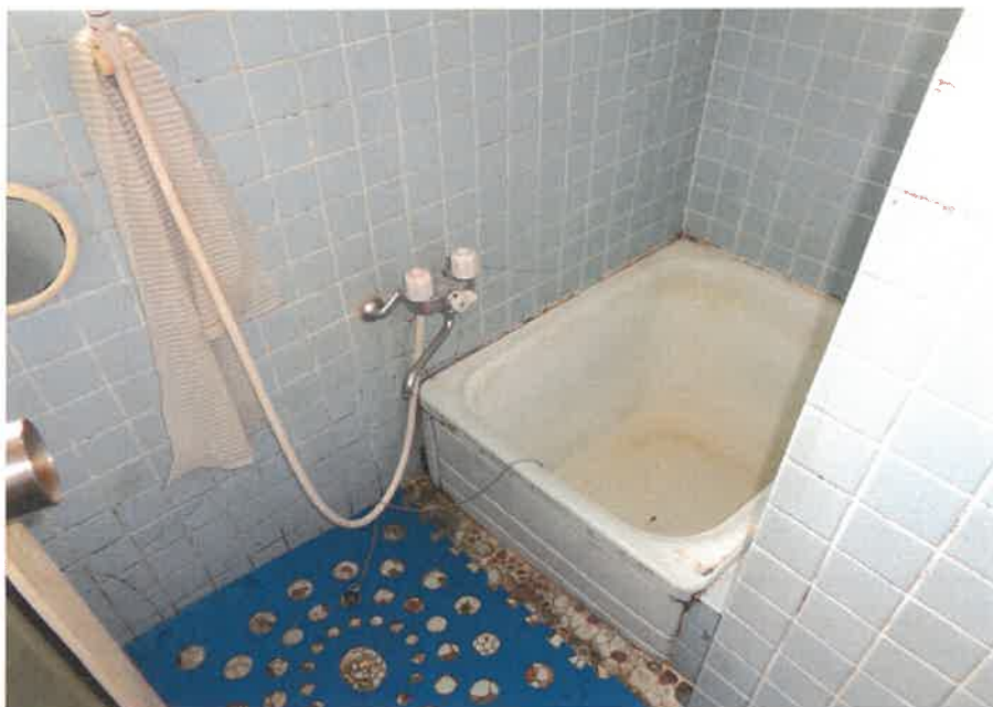
屋内の状況 浴室
