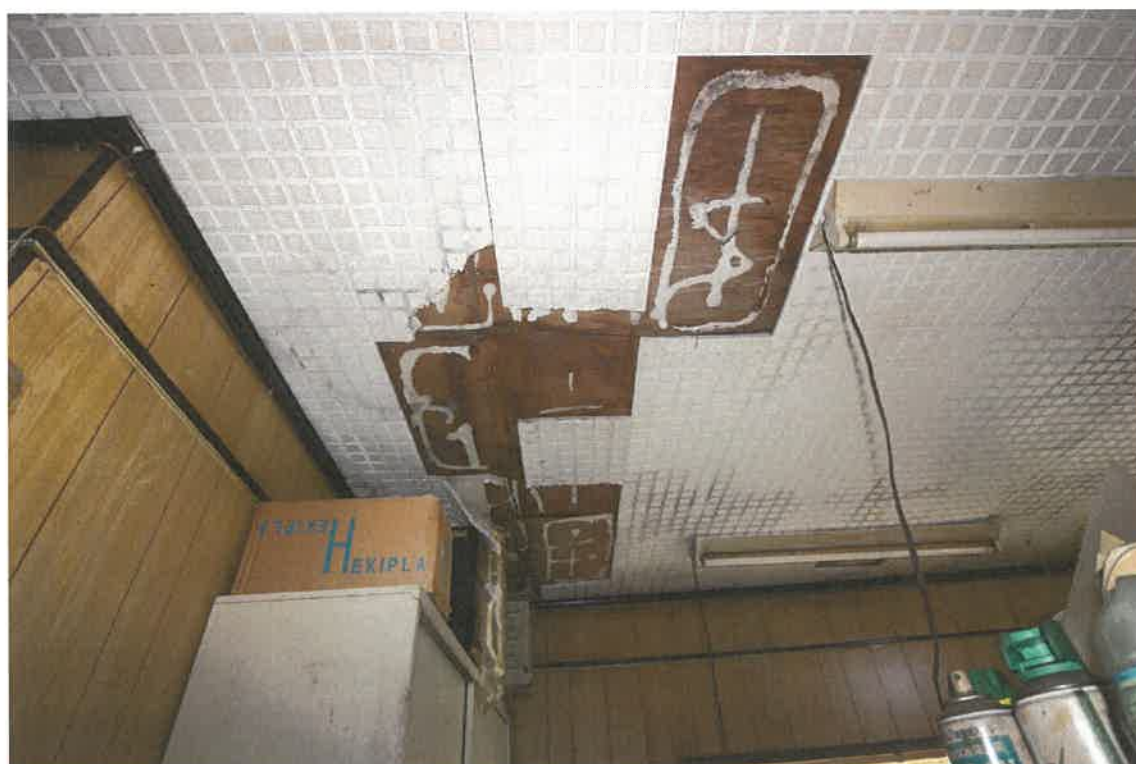
物件 4 建物室内(事務所の天井の状況)
