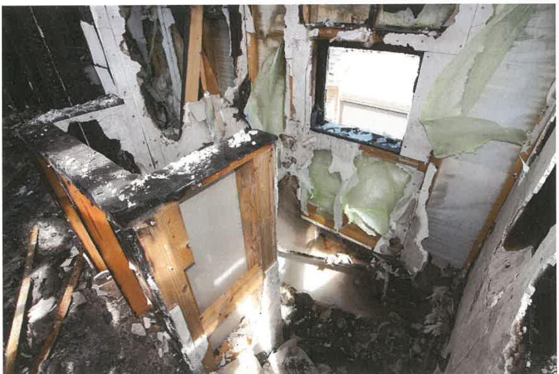
物件 4 建物 2階階段付近
