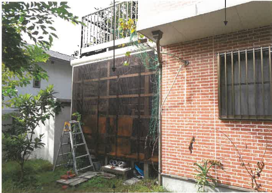
③ 本件建物の未登記増築部分（物置） 本件建物
