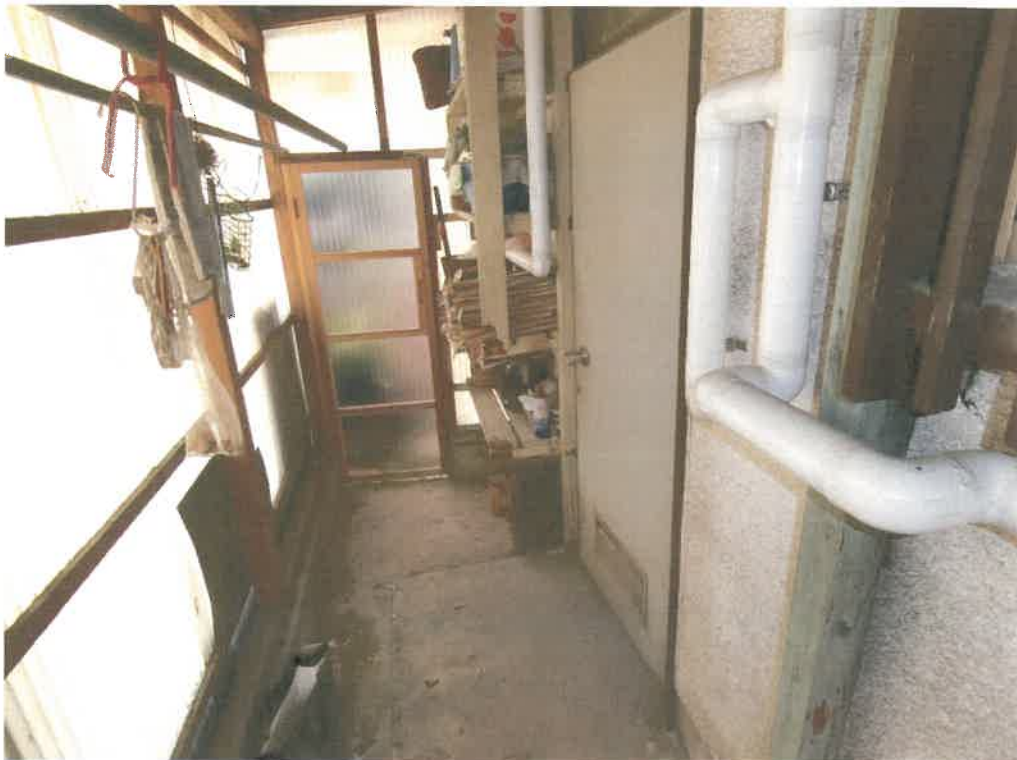
8 物件2内部の状況（勝手口北東側の増築部分）
