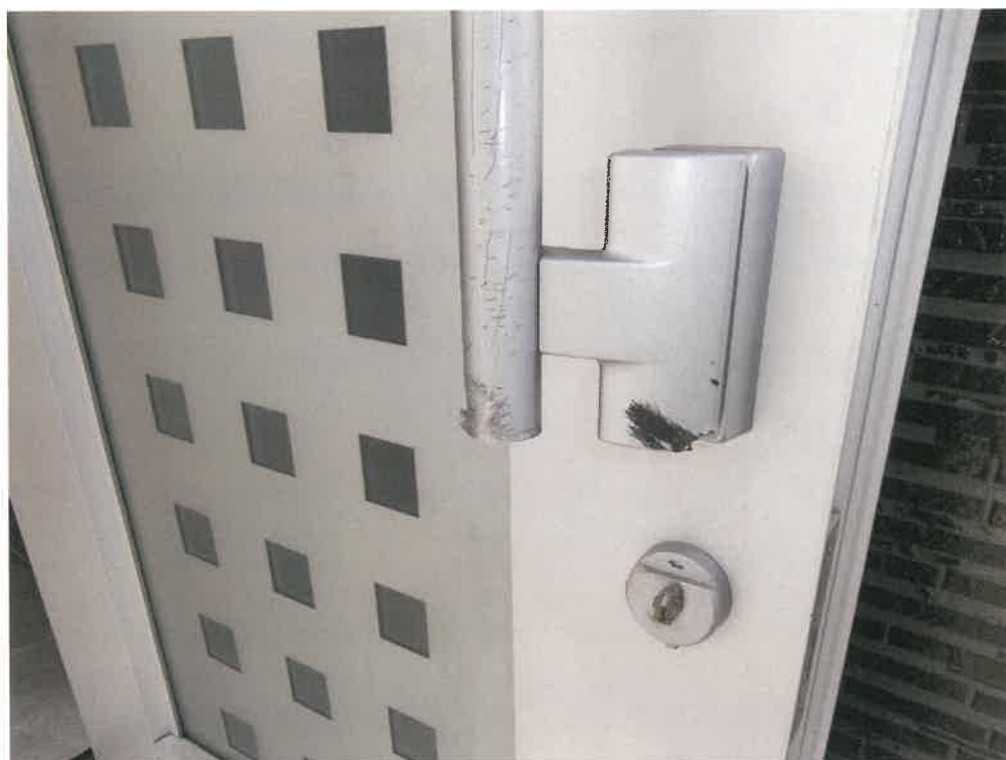
1 2 物件 2 内部の状況（玄関ドアの把手及びサムターンの損傷）
