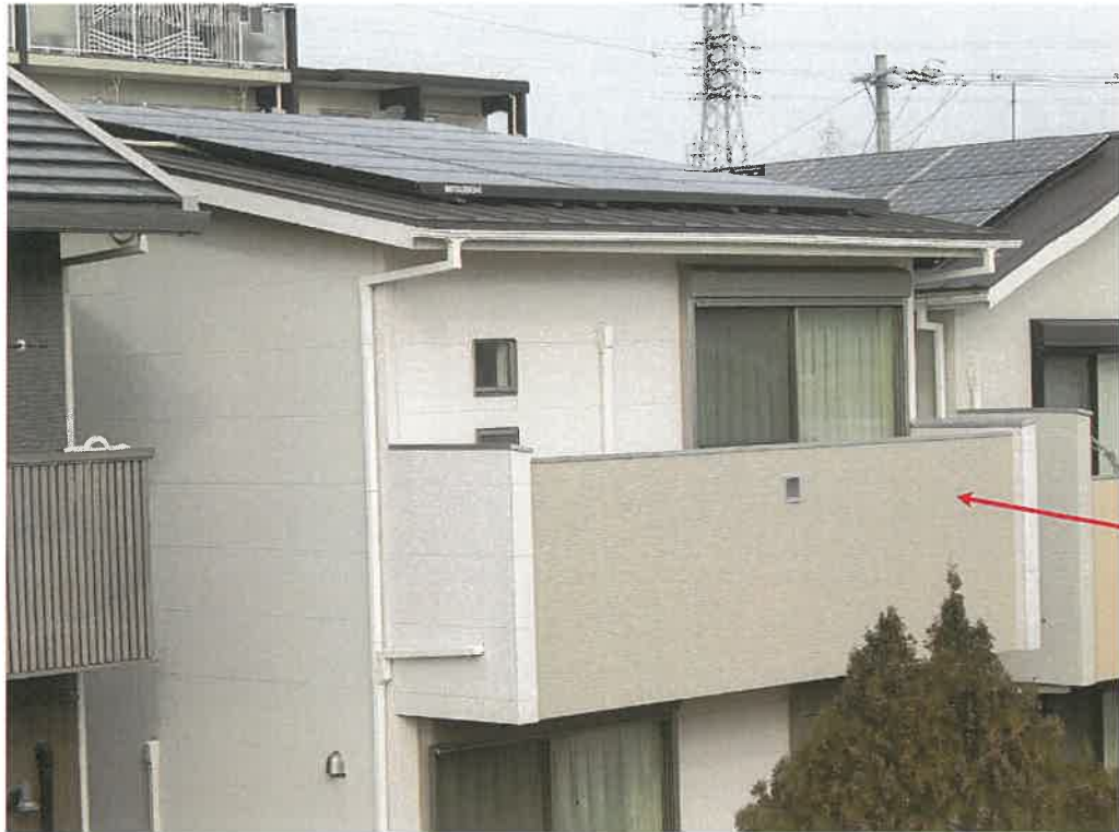
3 物件2の屋根に設置された太陽光発電パネル
