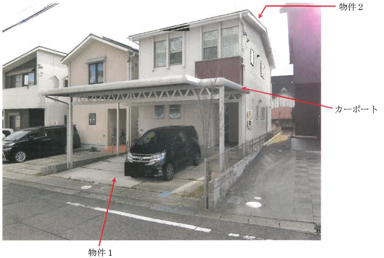
1 物件1及び2の外観（北西方向から撮影）
