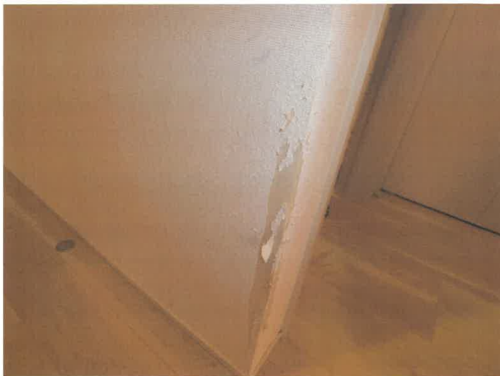
7 物件2内部の状況（クロスの損傷（キッチン北東側））
