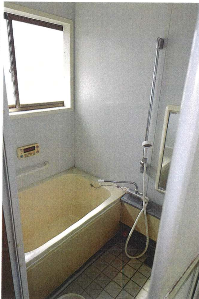
⑧ 屋内の状況（浴室）
