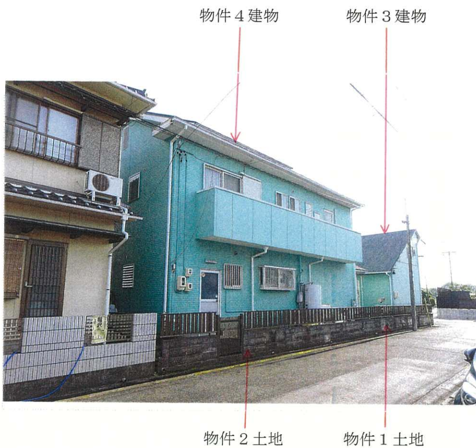
② 物件 1、2 土地、物件 3、4 建物の外観（北東方向から撮影）
