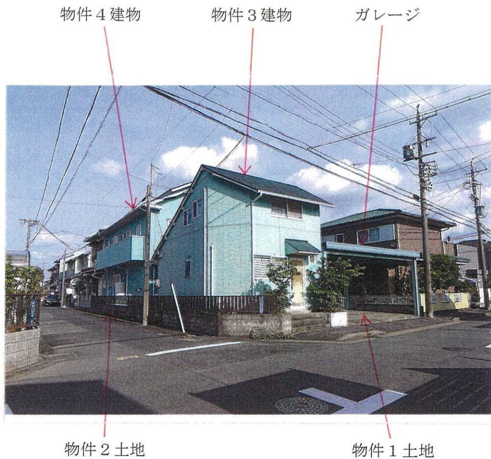
① 物件 1、2 土地、物件 3、4 建物の外観（北西方向から撮影）
