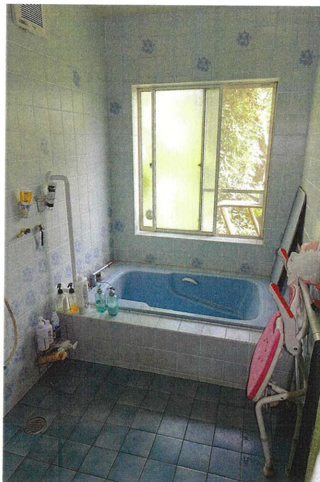
⑧ 屋内の状況（浴室（物件4建物））
