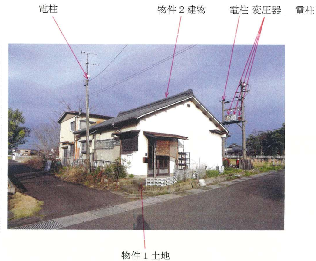
② 物件1土地、物件2建物の外観（西方向から撮影）
