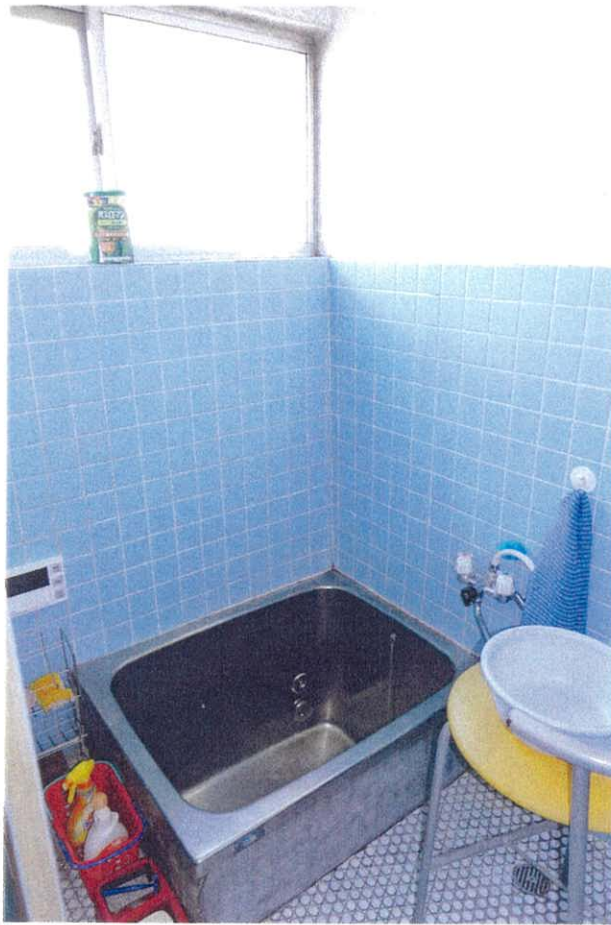
⑤ 屋内の状況（浴室）
