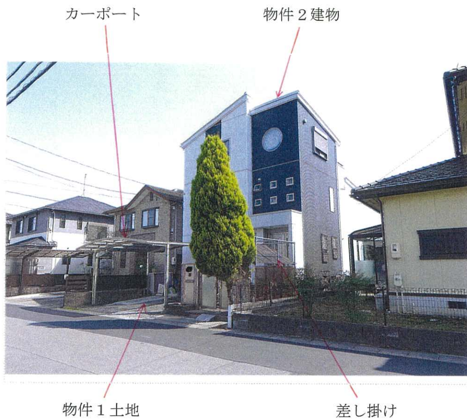
① 物件 1 土地、物件 2 建物の外観（北西方向から撮影）
