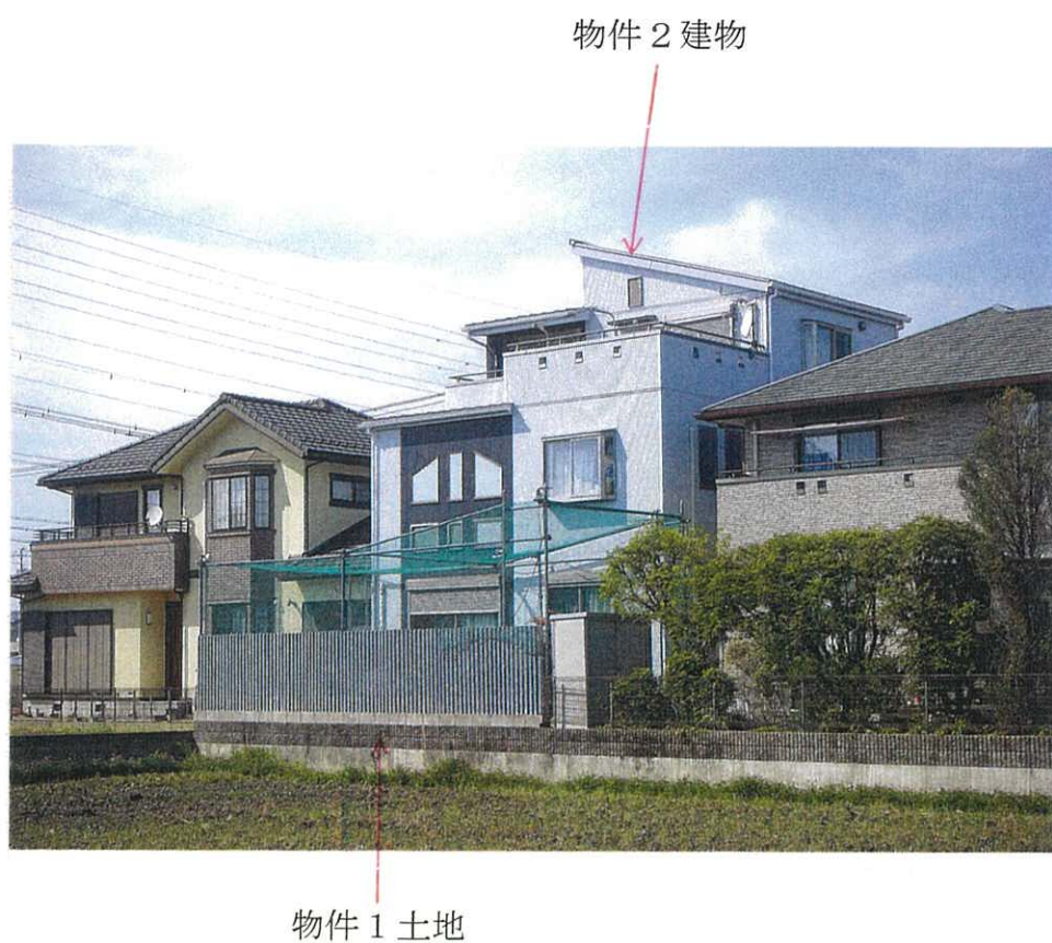
② 物件 1 土地、物件 2 建物の外観（南東方向から撮影）
