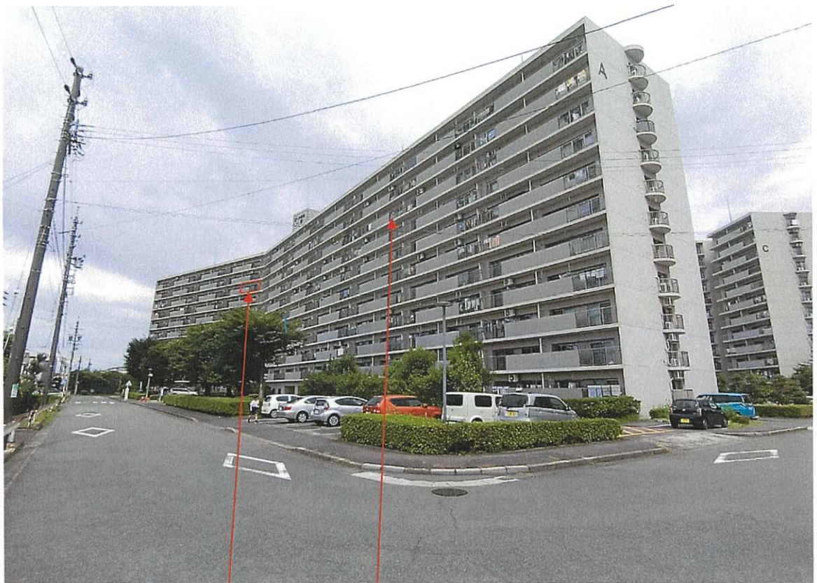
物件1 物件1の存する建物
