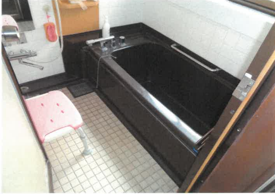
⑨ 屋内の状況 物件3建物 2階 浴室
