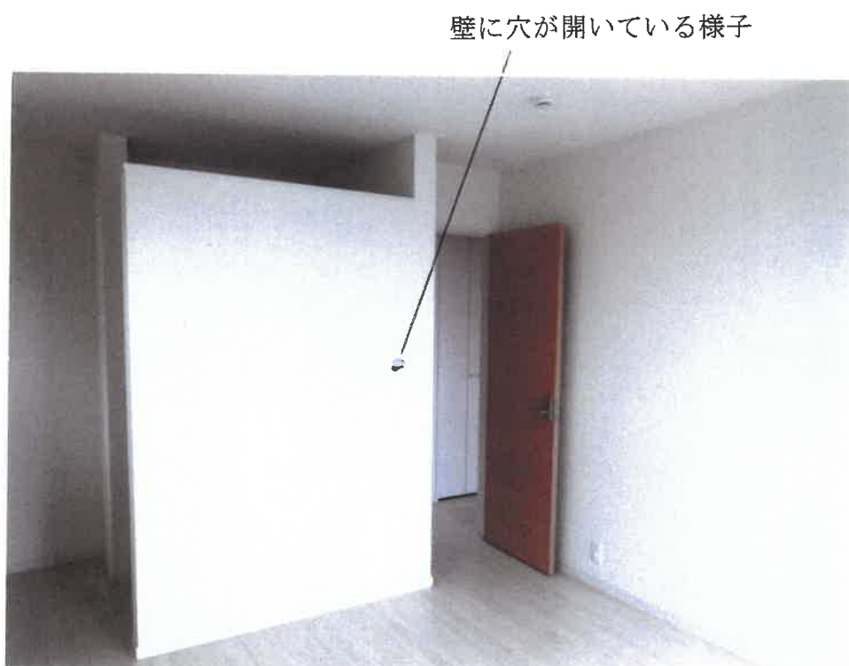
④ 屋内の状況（洋室 2）
