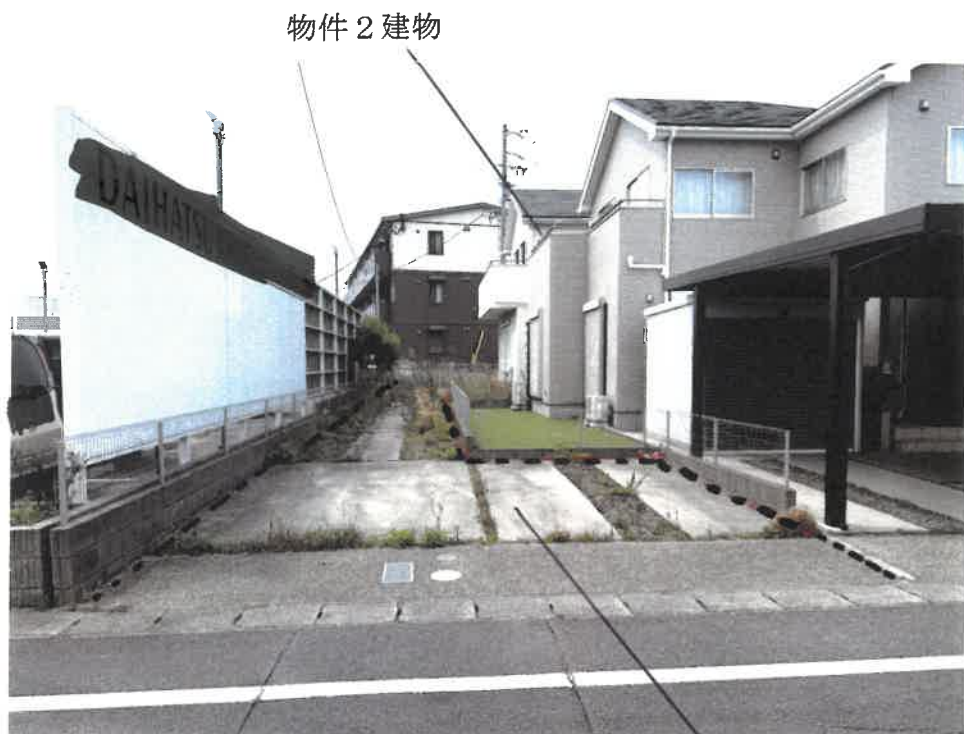
① 東方向から撮影
