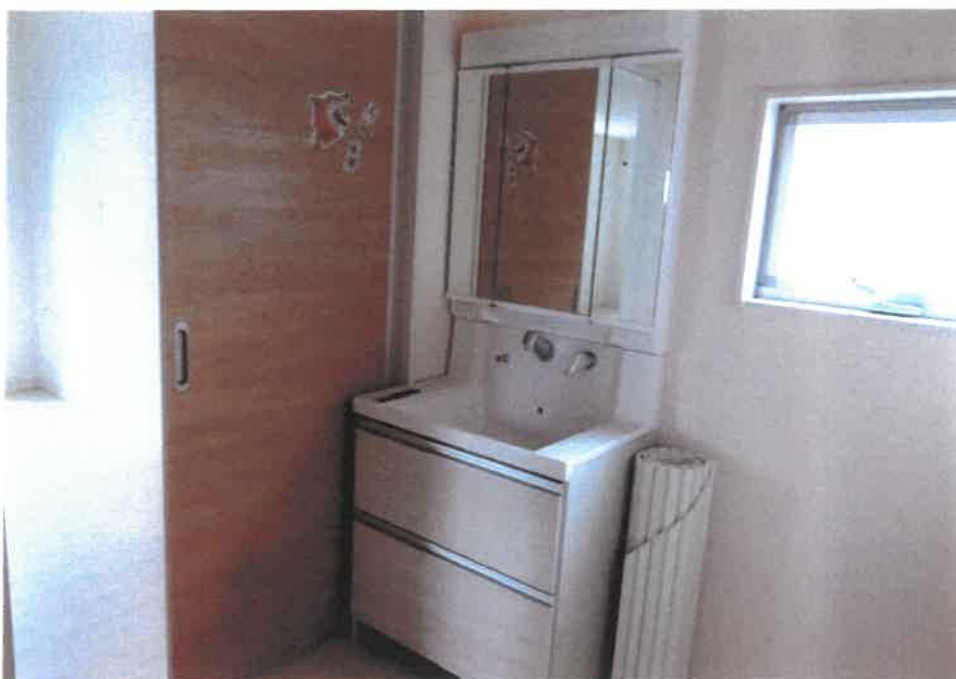
⑦ 屋内の状況（脱衣・洗面所）
