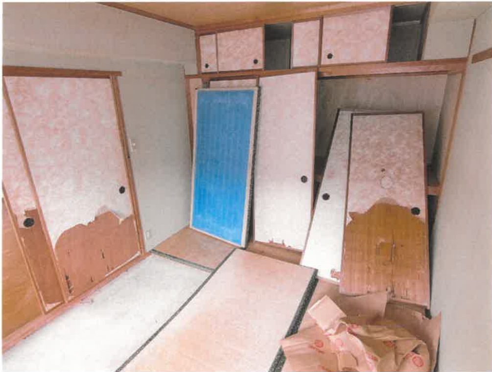
9 物件2建物内部の状況（N棟203号室・和室）
