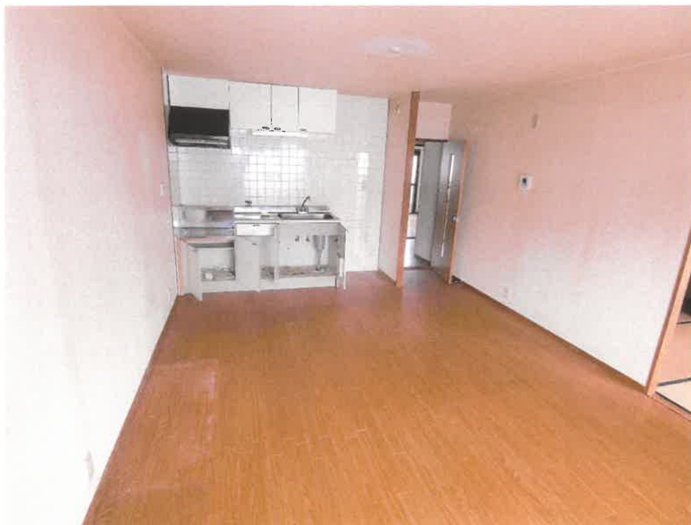
19 物件3建物内部の状況（S棟303号室・LDK）
