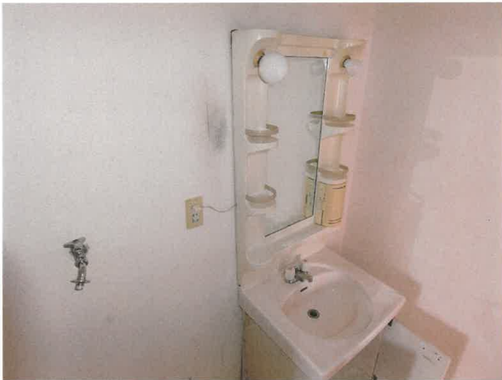
10 物件2建物内部の状況（N棟204号室・洗面所）
