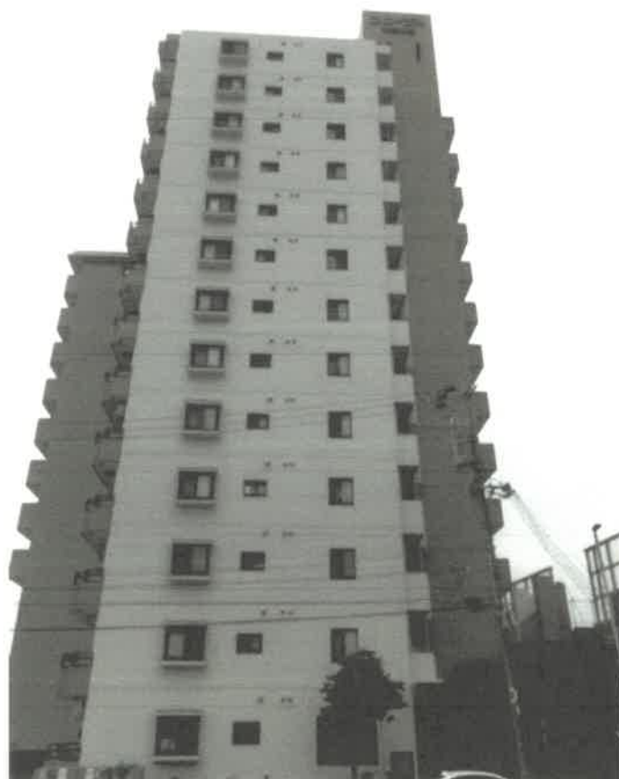
① 物件2建物を含む一棟の建物の外観（東方向から撮影）
