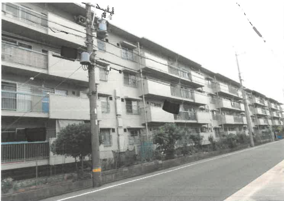
② 物件1建物を含む一棟の建物の外観（南西方向から撮影）
