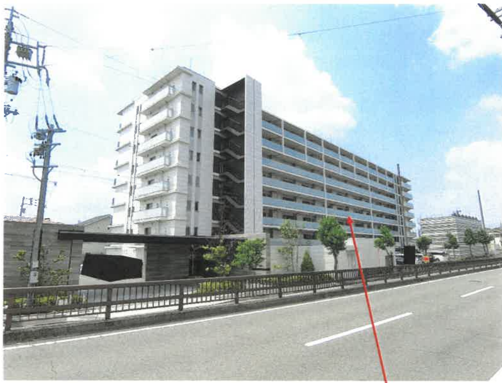
物件1建物を含む一棟の建物 （プレイズ旭前）
