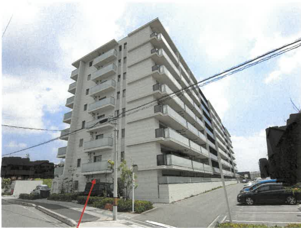
物件1建物を含む一棟の建物 （プレイズ旭前）
