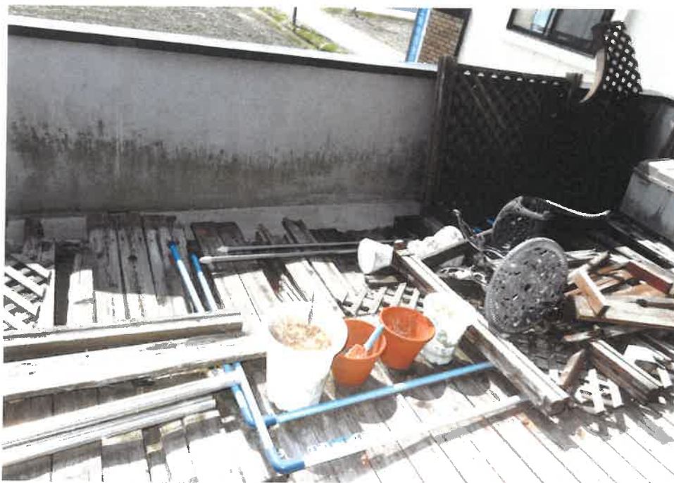
⑪ 2階バルコニーに設置されたウッドデッキの様子
