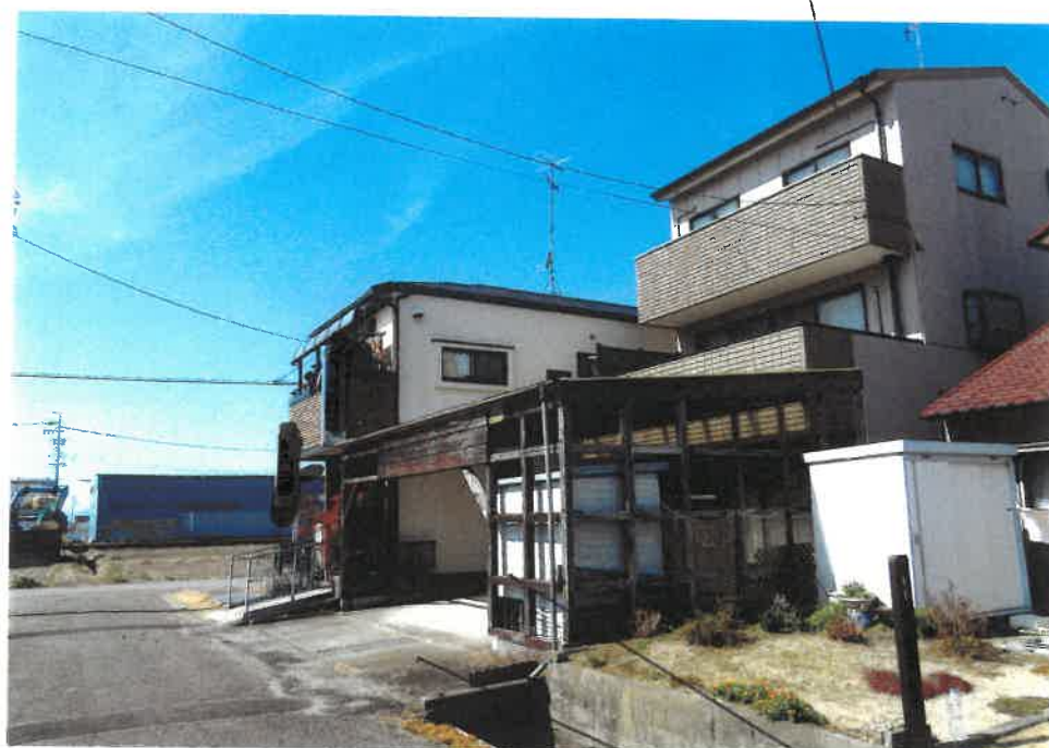
南側の水路上の橋 簡易物置
