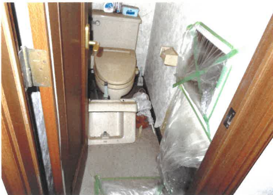
⑩ 屋内の状況（西側1階のトイレの様子）
