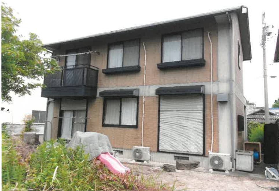
② 物件 1 建物の外観
