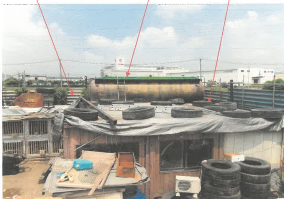
⑥ コンテナ2、タンク、ユニットハウス3
