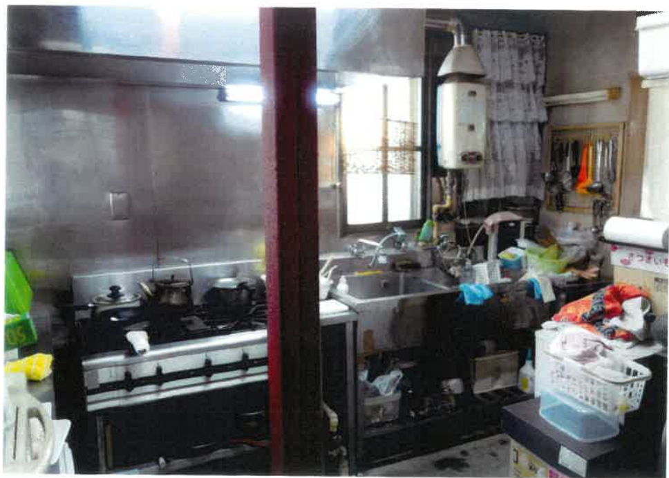
④ 屋内の状況（厨房1）
