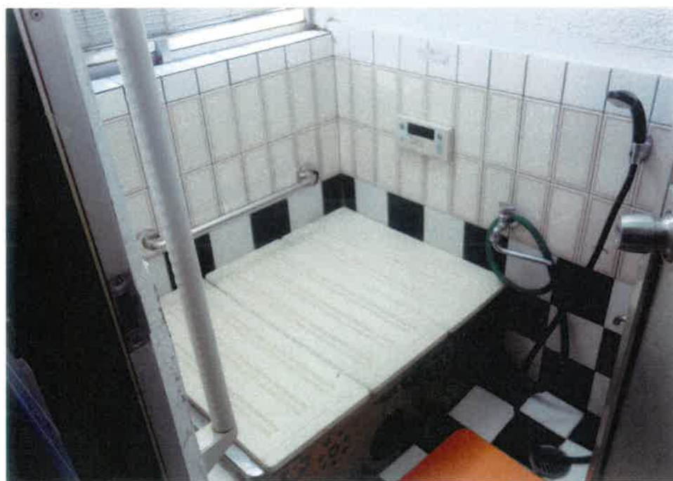
⑥ 屋内の状況（浴室）
