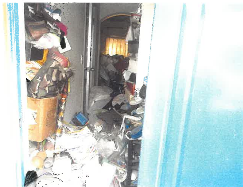
占有者長期間不在 屋内の状況（1階 102号室）
