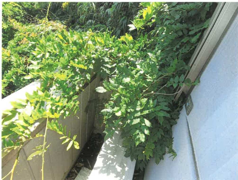
7 物件2建物の2階ベランダ
