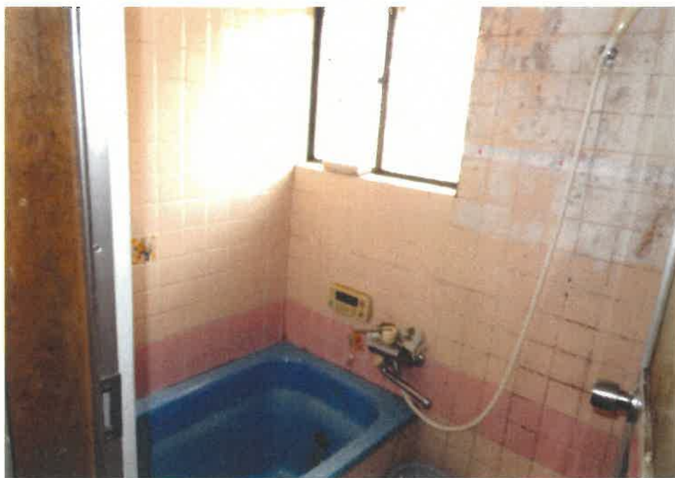
⑥ 屋内の状況（浴室の様子）
