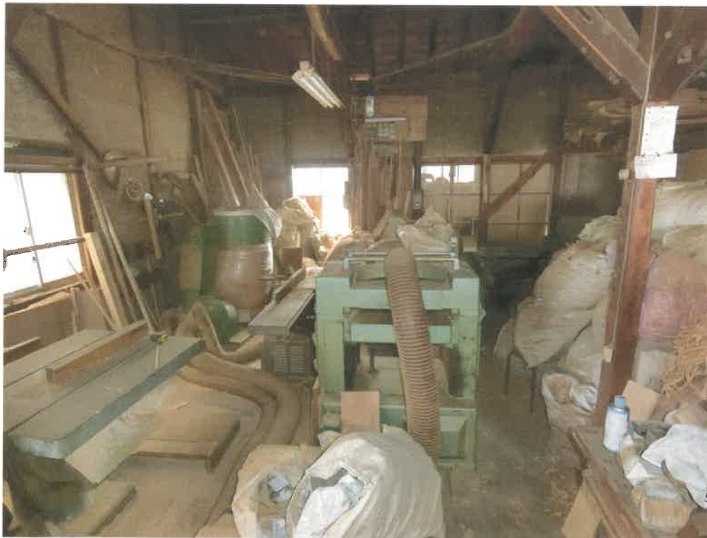
5 物件1主である建物内部の状況（作業所1）
