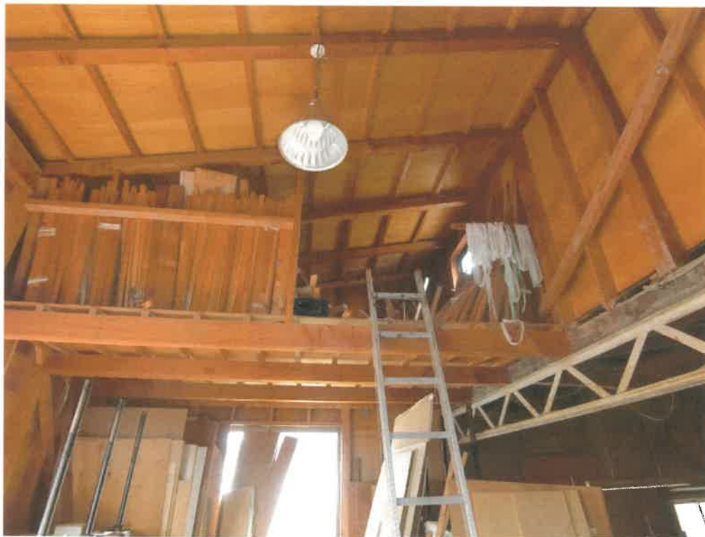
6 物件1主である建物内部の状況（物置2）
