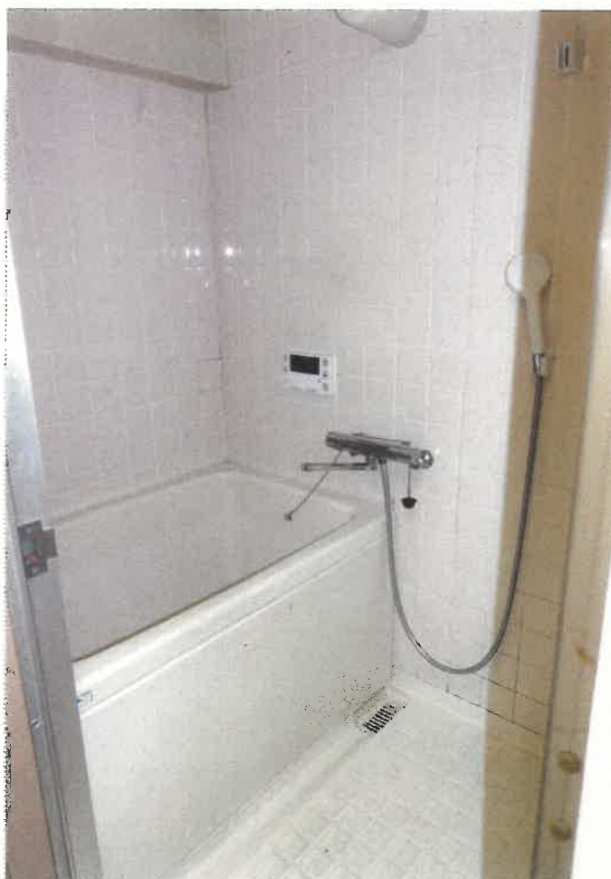
⑥ 屋内の状況（浴室）
