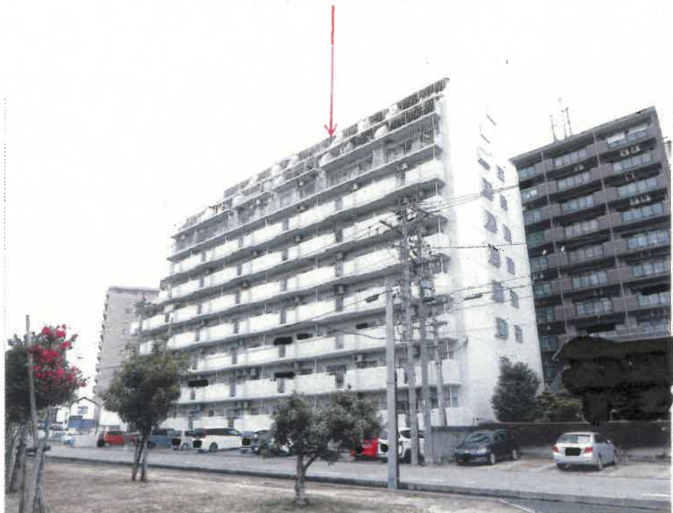
物件1 建物を含む一棟の建物
