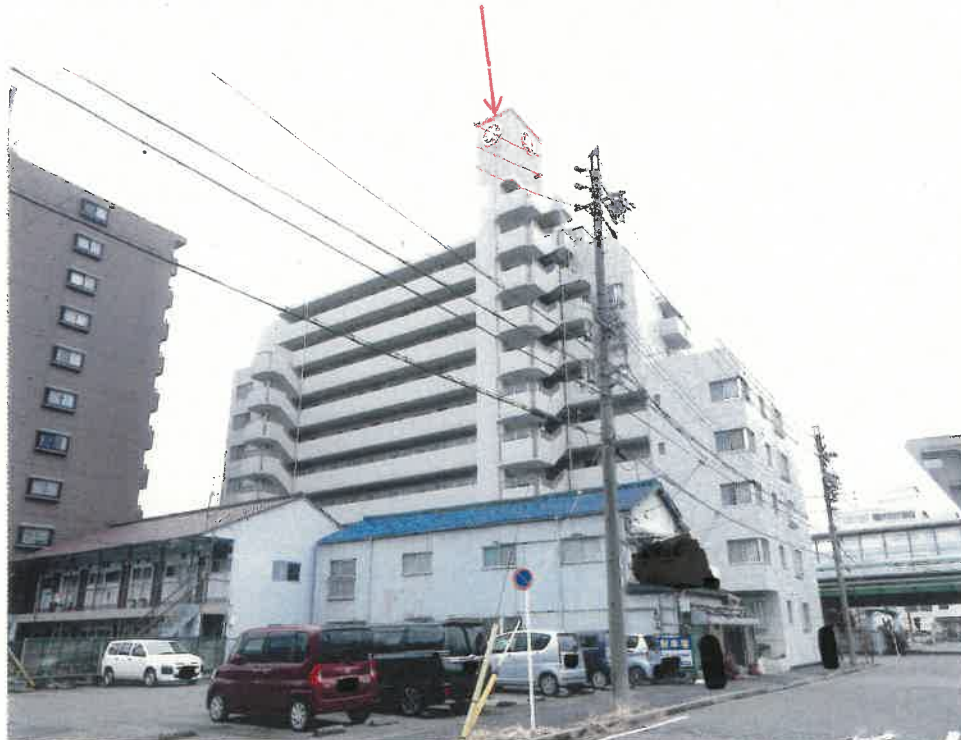
物件1 建物を含む一棟の建物
