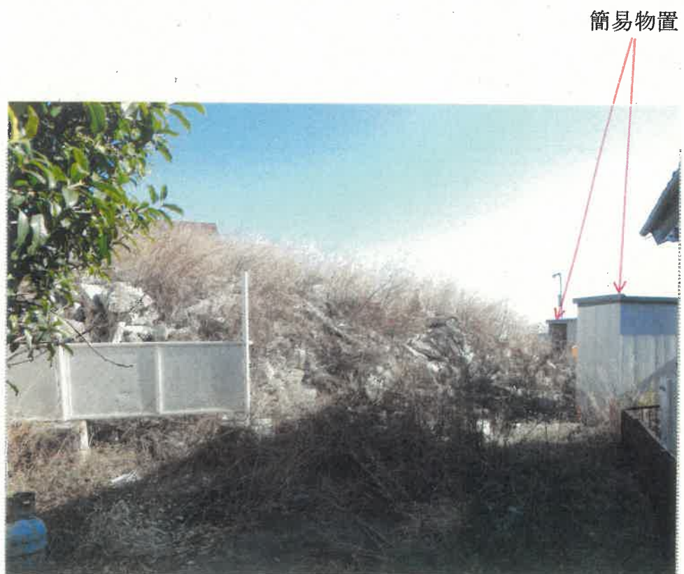
⑥ 本件各土地の状況（西方向から撮影）
