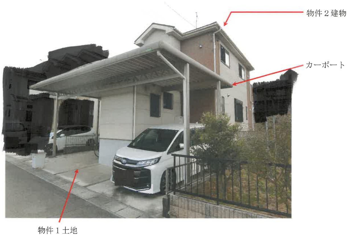
1 物件1土地及び物件2建物の外観（北西方向から撮影）
