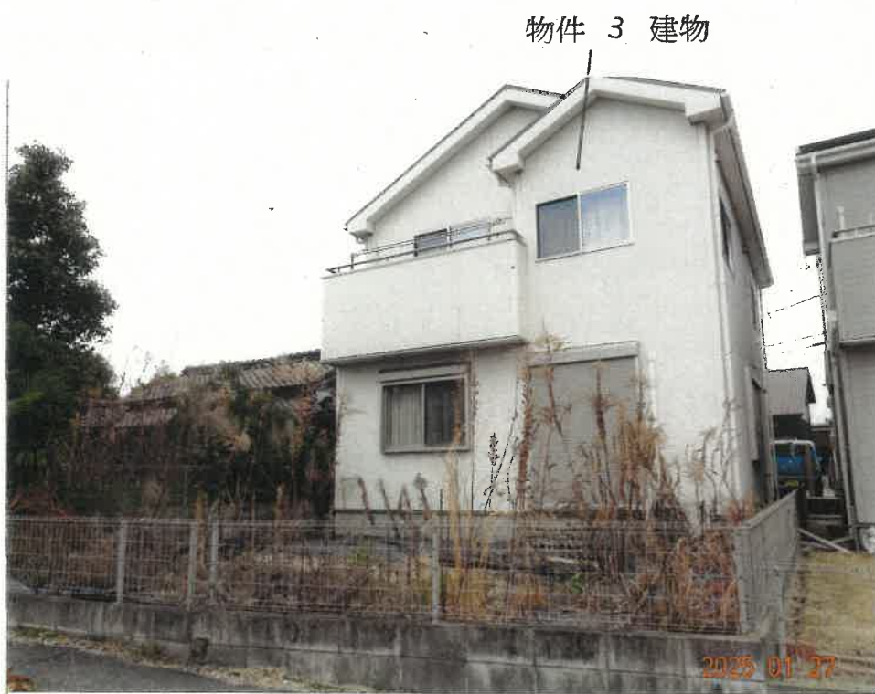
② 南側から見た物件 3 建物の状況
