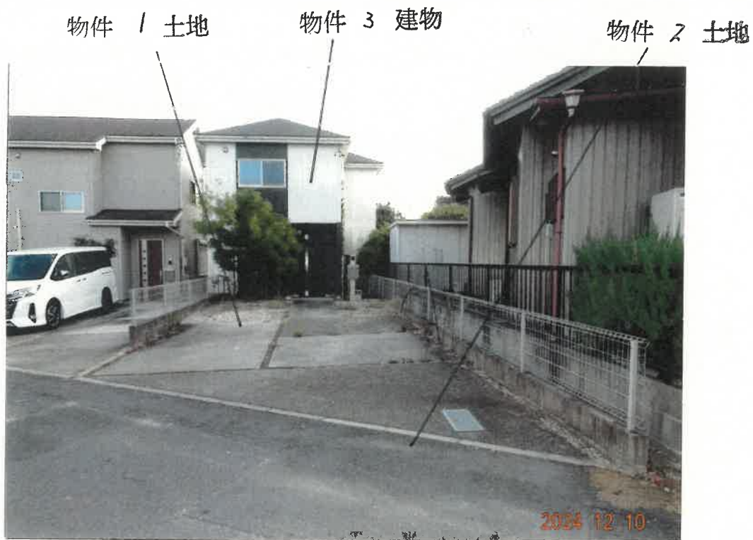
① 北側から見た物件 1 土地、物件 2 土地及び物件 3 建物の状況
