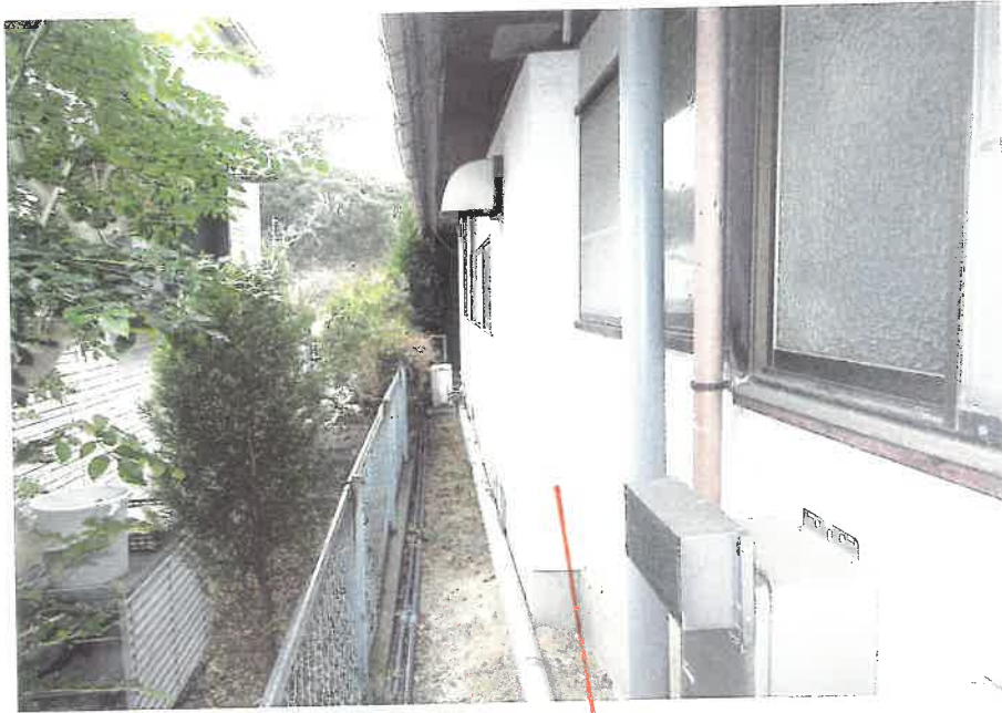
屋外の状況 (1階 増築部分)
