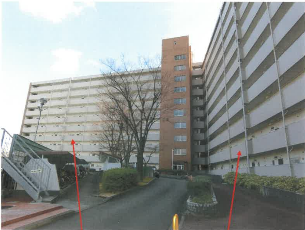
物件3建物を含む一棟の建物 (高針北住宅C棟)
