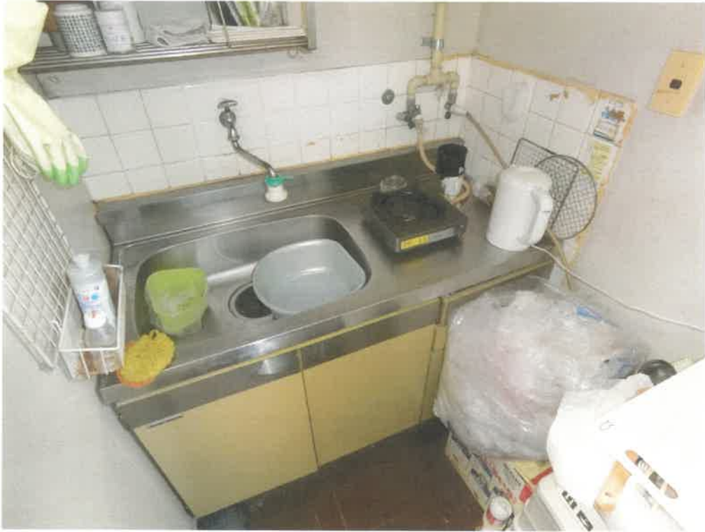
7 物件2建物内部の状況（ミニキッチン（事務室内））
