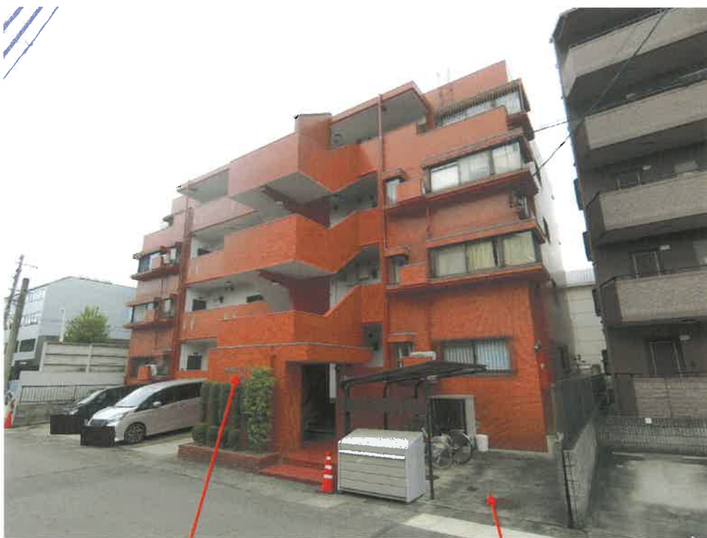
物件2建物を含む一棟の建物 （赤坂マンション石が根）
