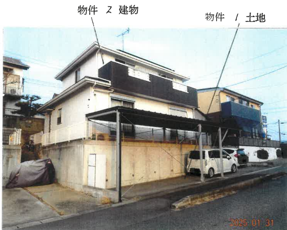
② 西側から見た物件 1 土地及び物件 2 建物の状況
