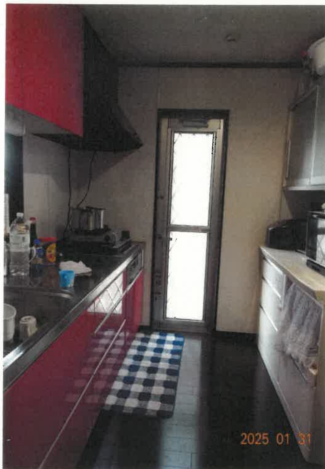
⑤ 屋内の状況（1階 キッチン）
