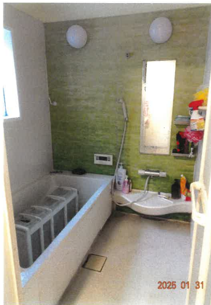
④ 屋内の状況（1階 浴室）
