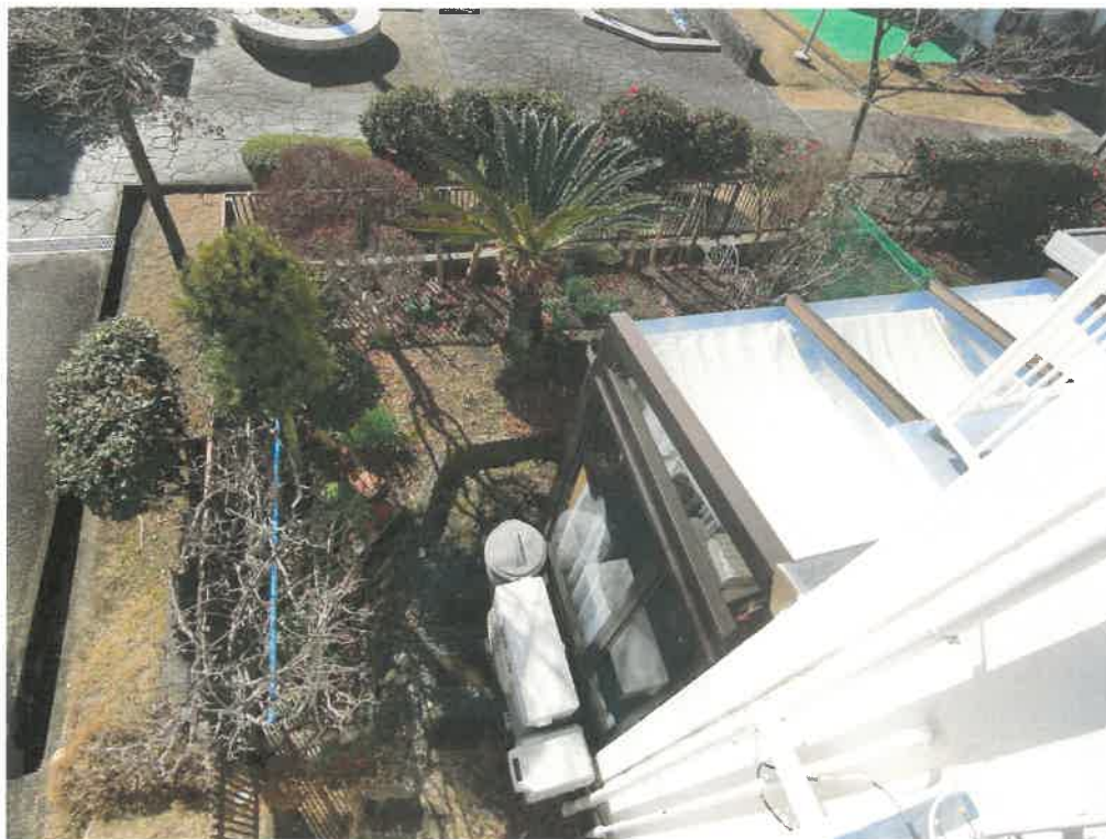
5 サンルームの外観（2階バルコニーから撮影）
