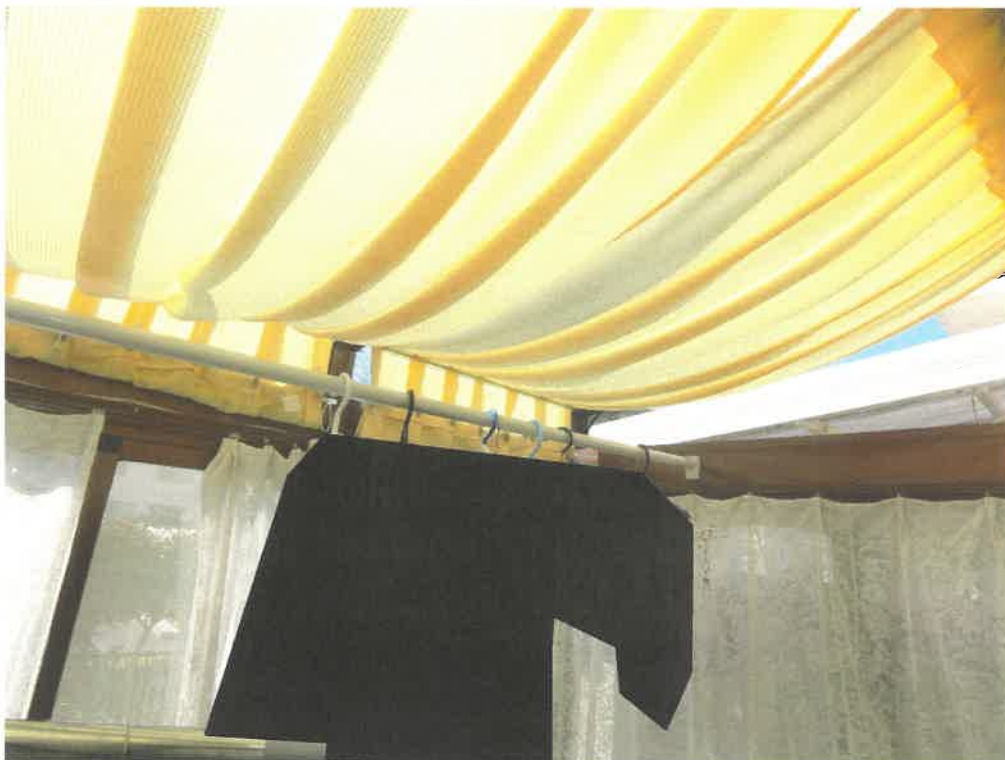
6 物件2建物内部の状況（サンルーム）
