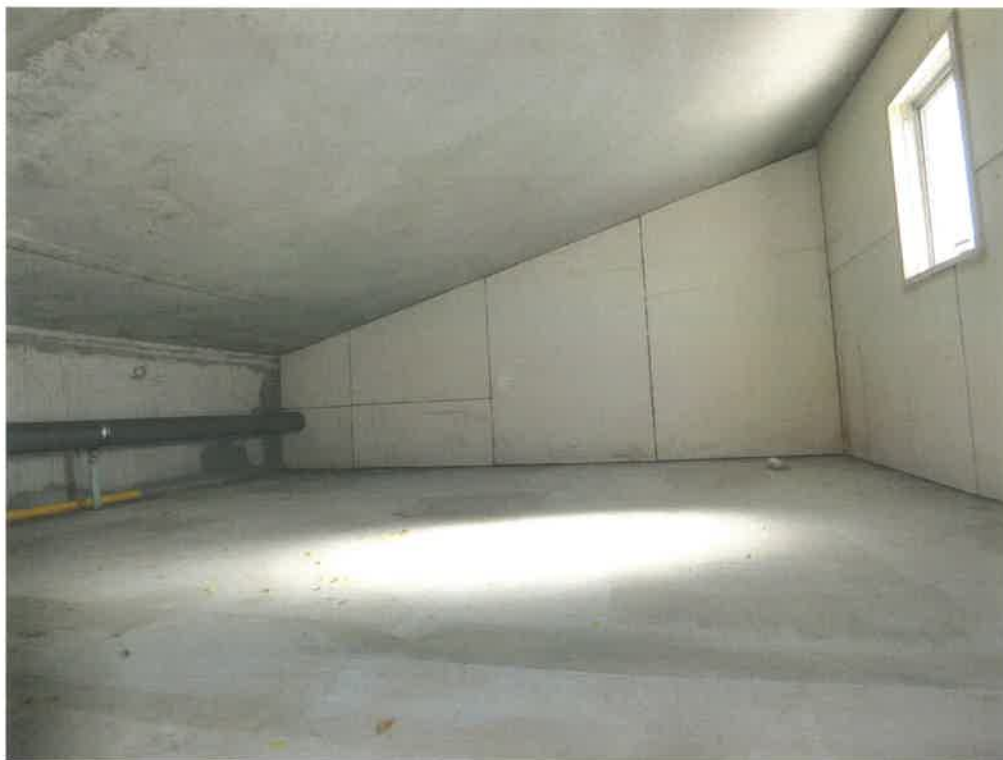
8 物件2建物内部の状況（小屋裏収納）
