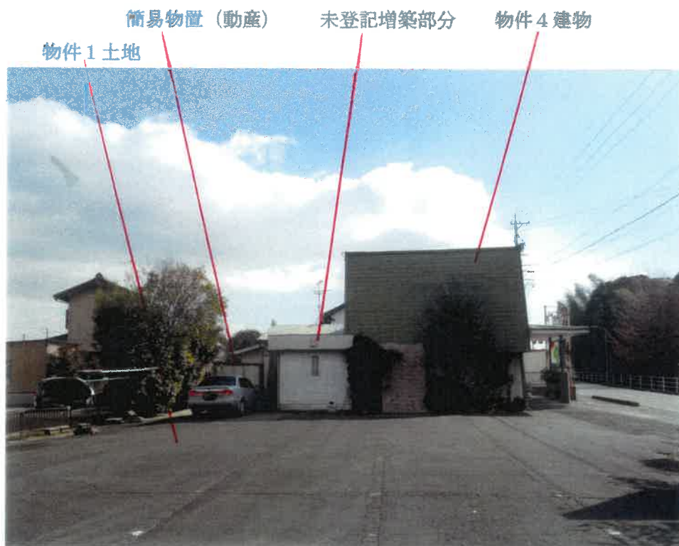
② 物件4建物の外観（西方向から撮影）
