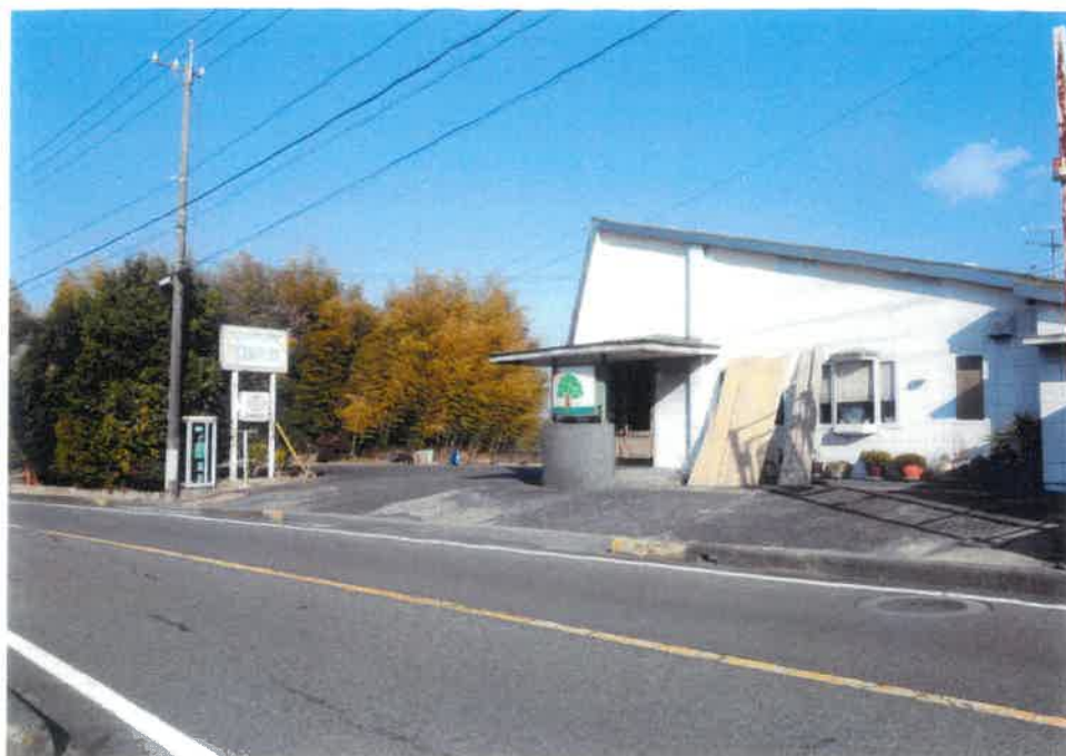
① 物件4建物の外観（南東方向から撮影）
