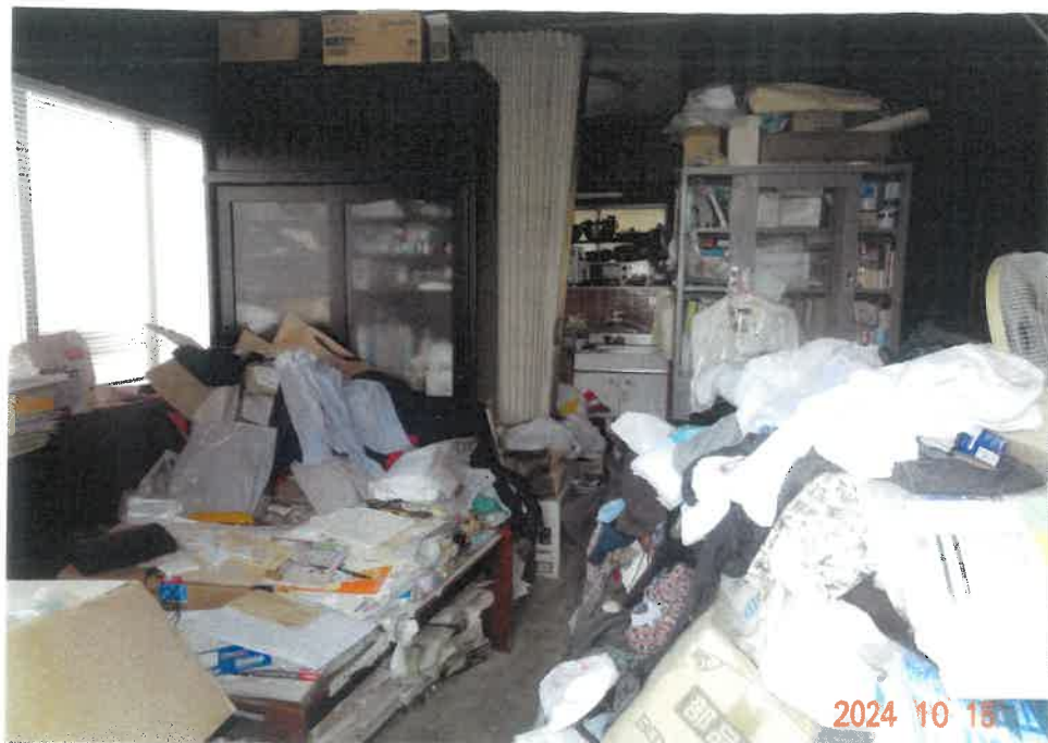
⑧ 物件4建物の屋内の状況（1階 事務所）
