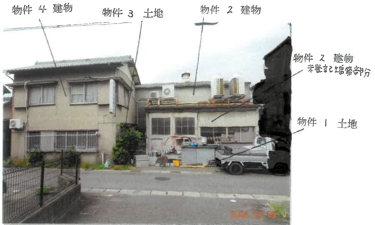
① 南側から見た物件 1 土地、物件 3 土地、物件 2 建物及び物件 4 建物の状況
