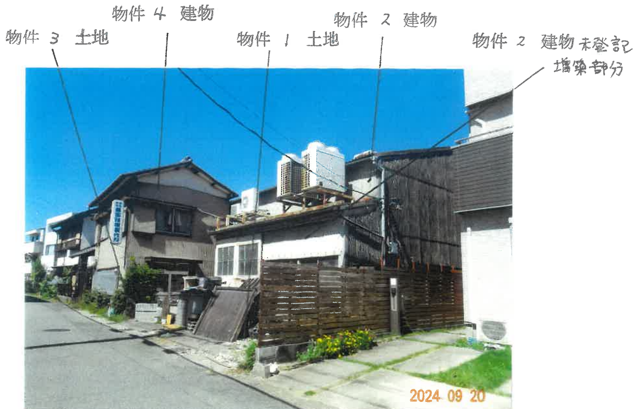
② 南東側から見た物件 1 土地、物件 3 土地、物件 2 建物及び物件 4 建物の状況
