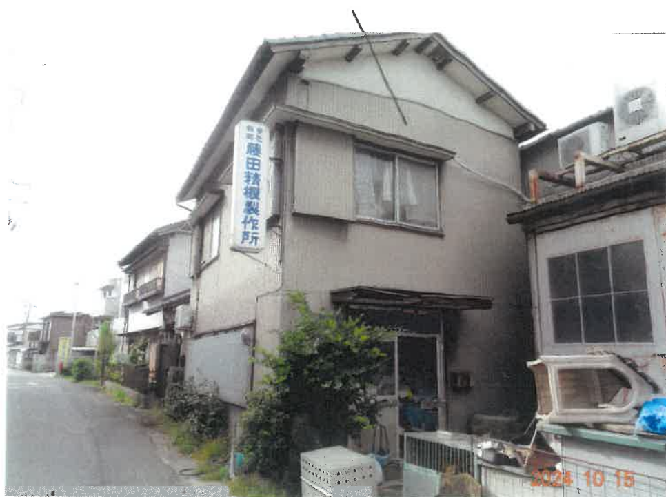
③ 物件 4 建物の状況
