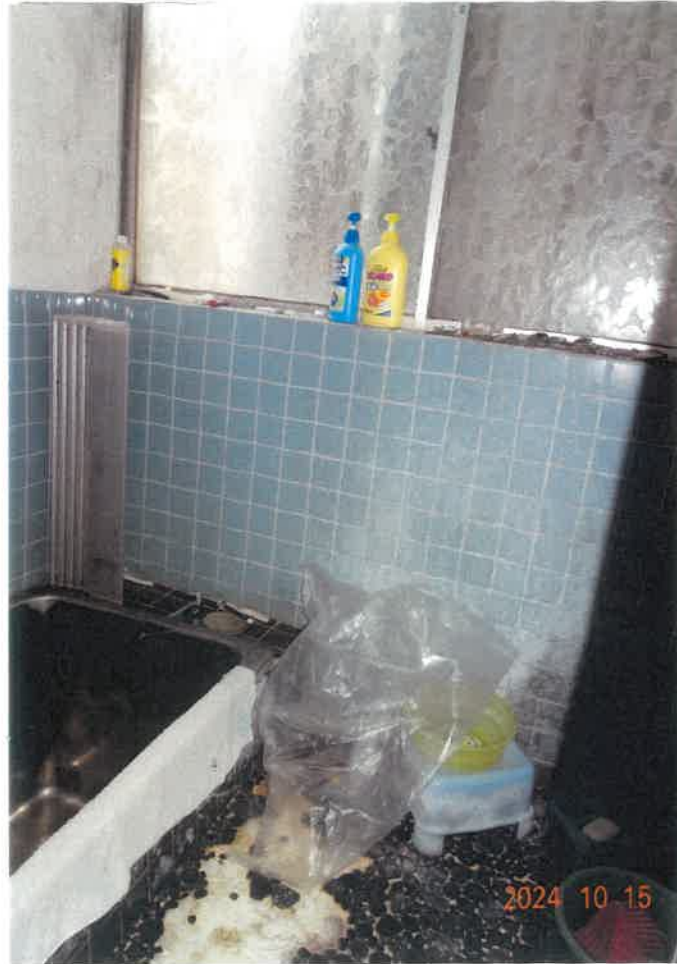
⑫ 物件4建物の屋内の状況（1階 浴室）
