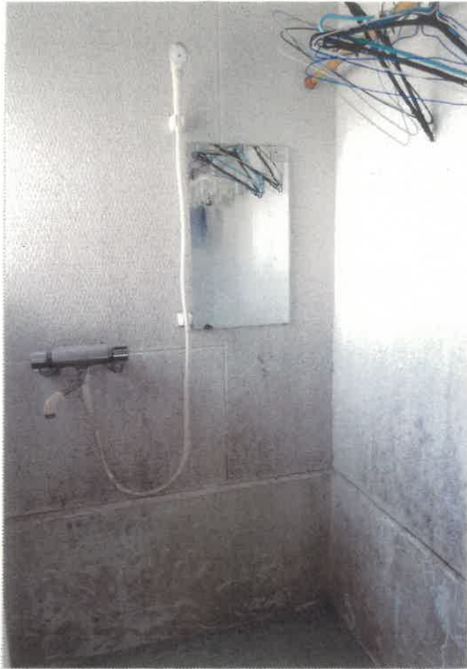
⑦ 屋内の状況（シャワー室）
