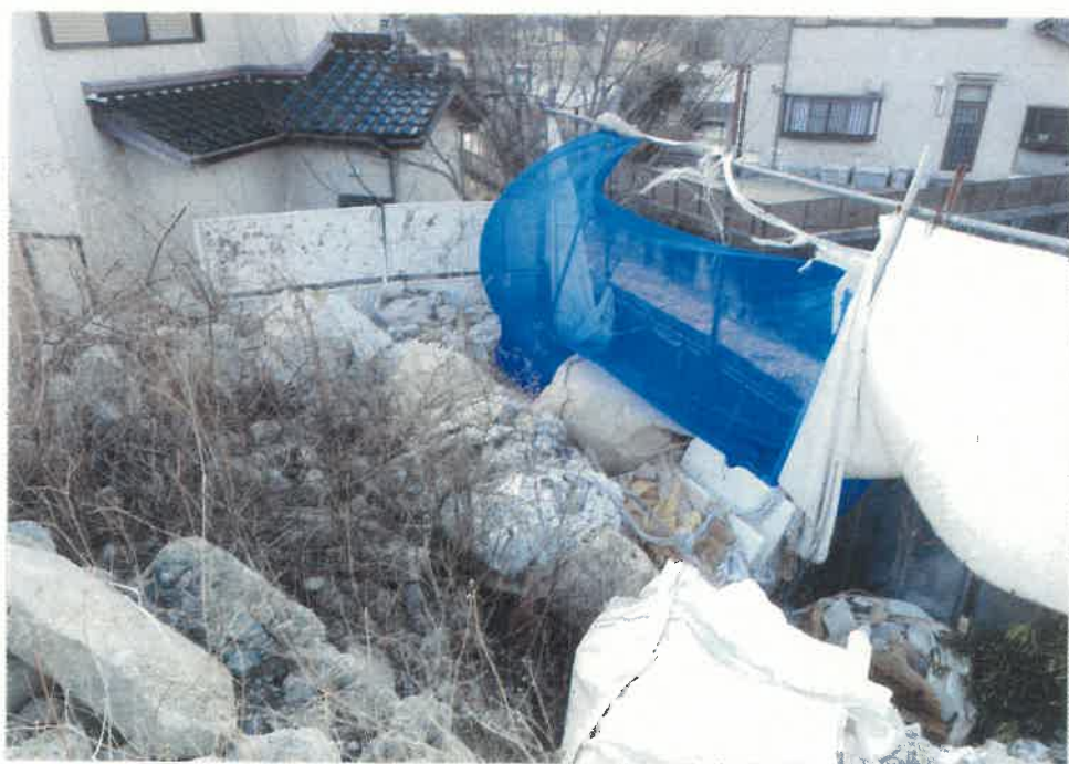
④ 本件各土地の状況（北西側付近を撮影）
